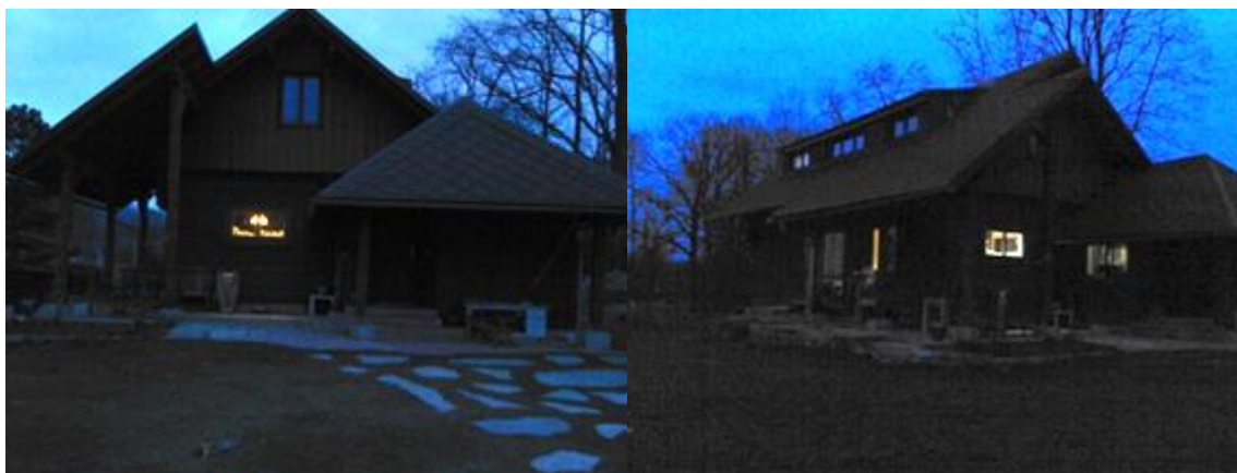
Obrázek č. 46 a 47 – venkovní stěna měřené místnosti vyfocen bez a s termovizí
