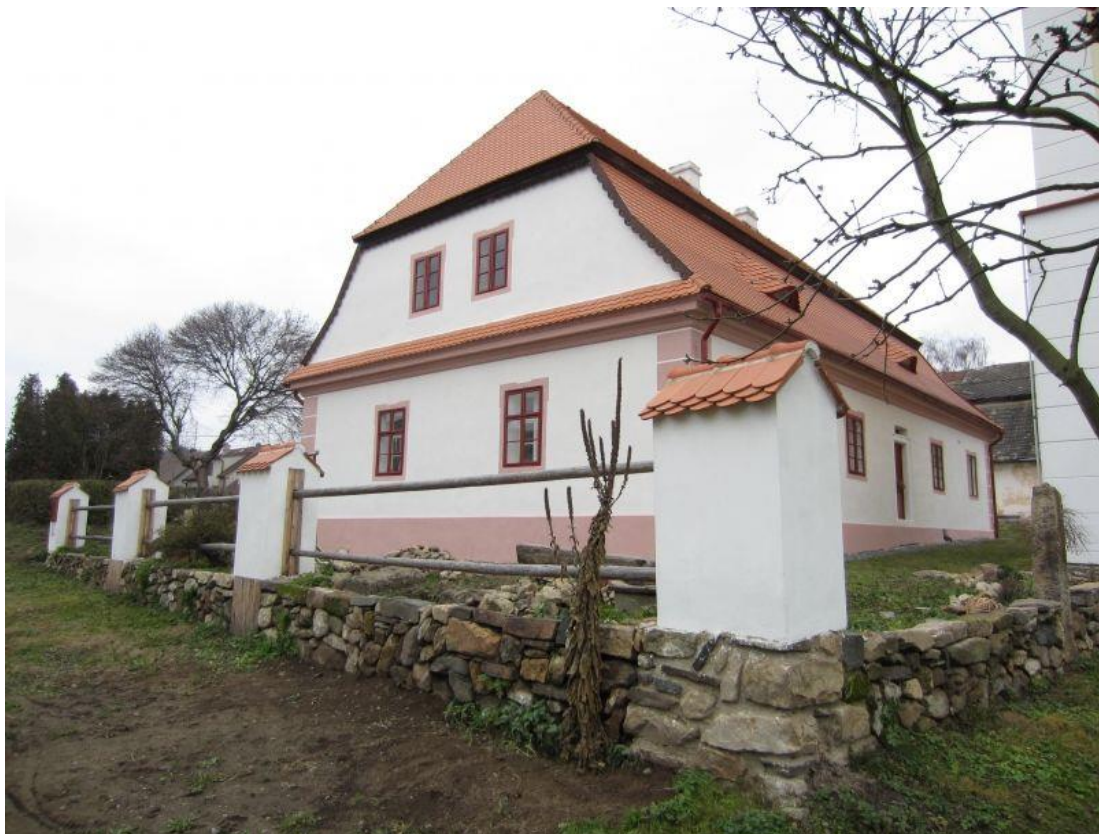
Obrázek 24: Stav objektu po rekonstrukci [ https://nadasvoboda.cz/stara-skola-v-bobrove/ ]
