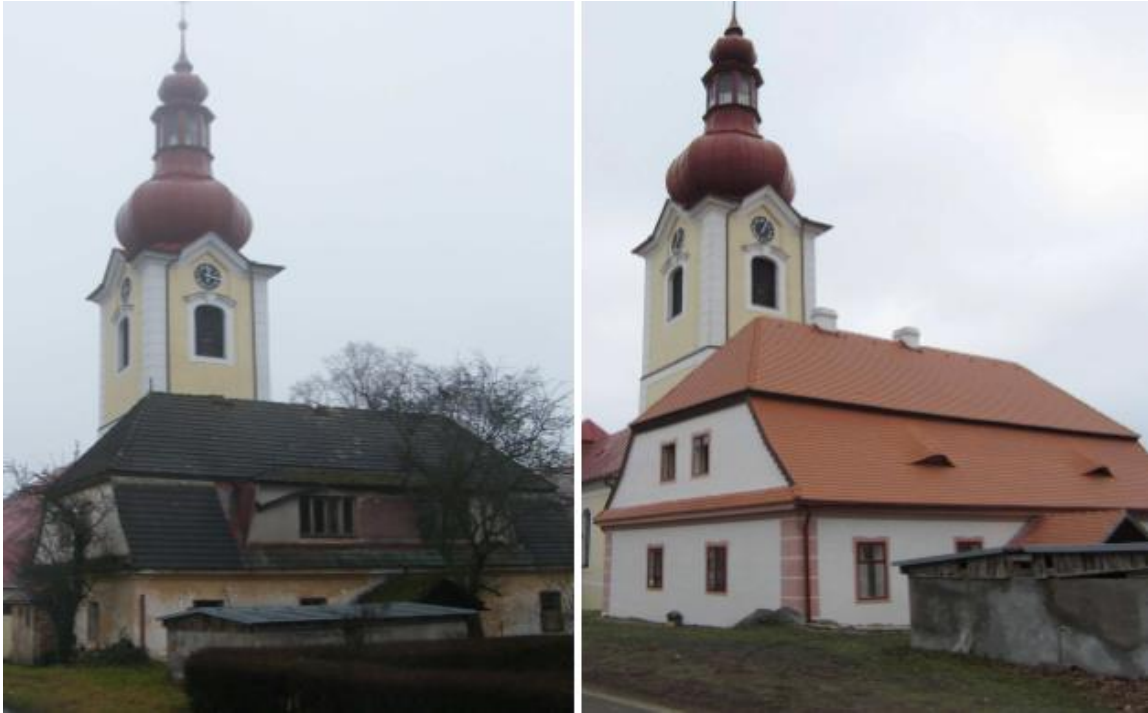
Obrázek 23: Stav objektu před a po rekonstrukci [ https://nadasvoboda.cz/stara-skola-v-bobrove/ ]
