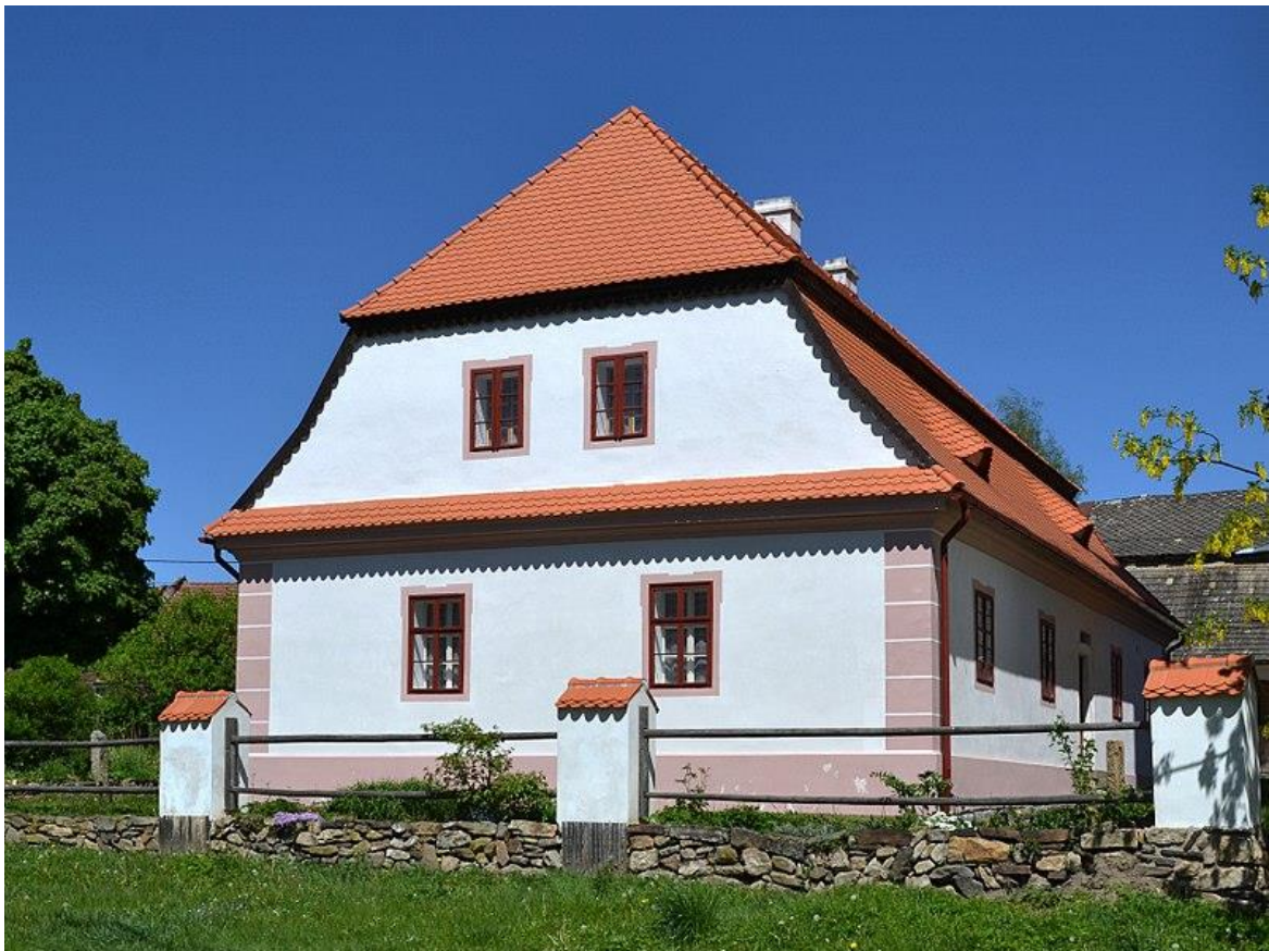
Obrázek 5: Budova bývalé školy na Horní Bobrové po rekonstrukci [ https://cs.wikipedia.org/wiki/Soubor:Horn%C3%AD_Bobrov%C3%A1_star%C3%A1_%C5%A1kola,_%C4%8Dp.148.jpg ]
