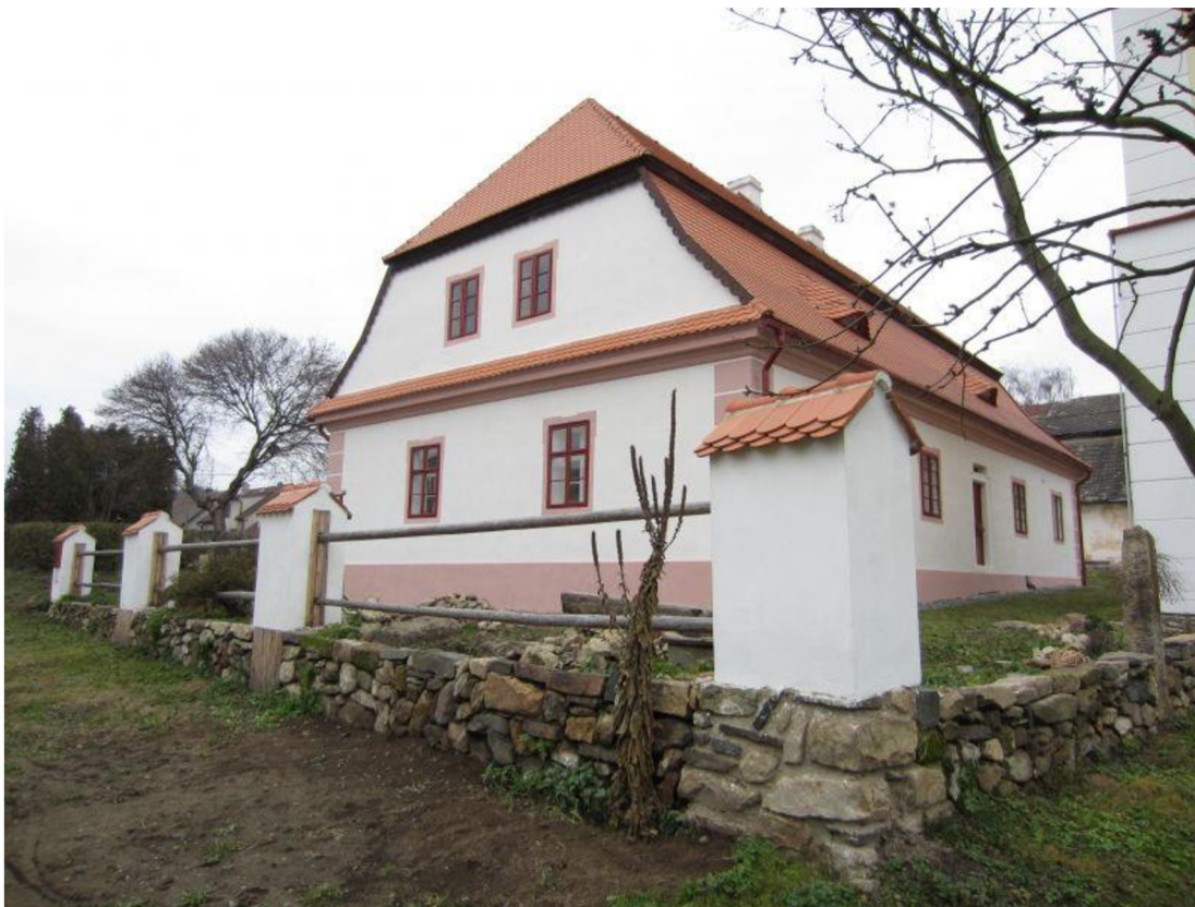
Obrázek 24: Stav objektu po rekonstrukci [ https://nadasvoboda.cz/stara-skola-v-bobrove/ ]
