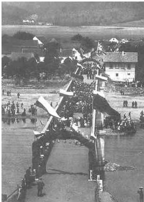
Obr. č. 13: Most přes řeku Berouнку v Dobřichovicích v roce 1897 (Geocaching ©2019)
