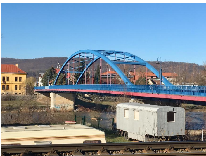
Obr. č. 14: Most přes řeku Berouнку v Dobřichovicích v roce 2019 (vlastní foto)
