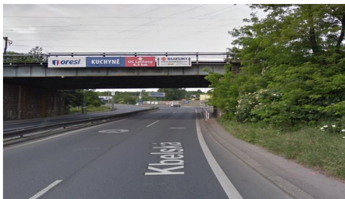
Obr. 4- 18 Bod- 3 Průjezd pod viaduktem v ulici Kbelská
