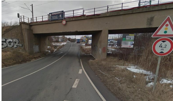
Obr. 4- 21 Bod- 1 Průjezd pod viaduktem v ulici Nedokončená
