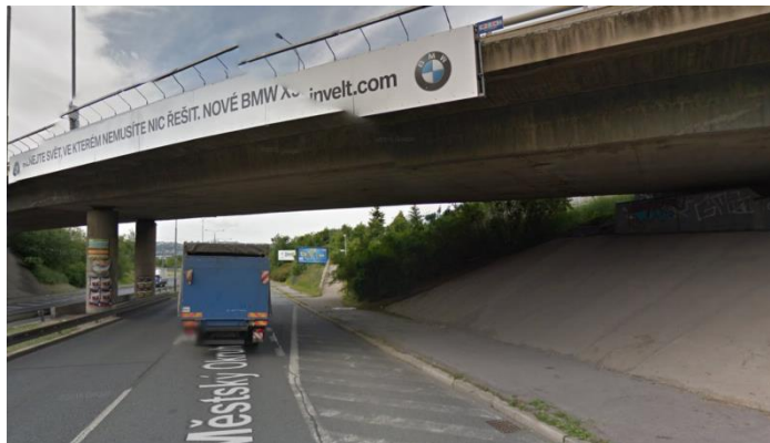
Obr. 4- 17 Bod- 2 Průjezd pod mostem v ulici Průmyslová
