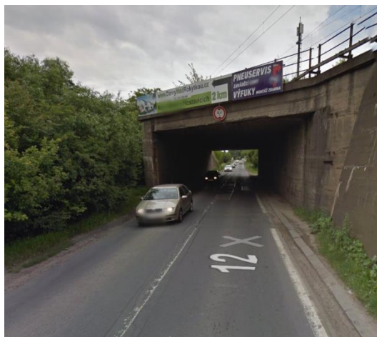
Obr. 4- 23 Bod- 3 Průjezd pod viaduktem v ulici Českobrodská
