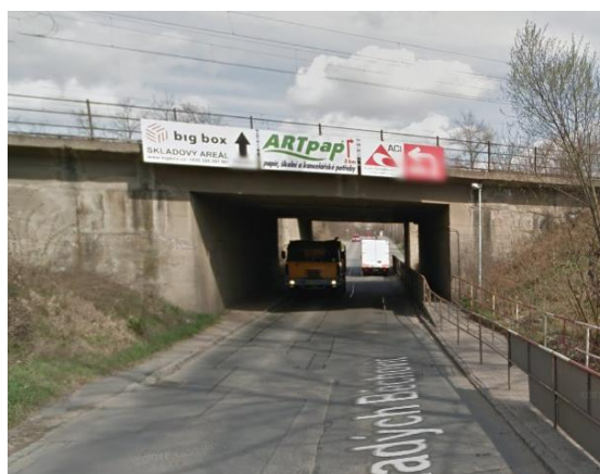
Obr. 4- 25 Bod- 5 Průjezd pod viaduktem v ulici Mladých Běhovic
