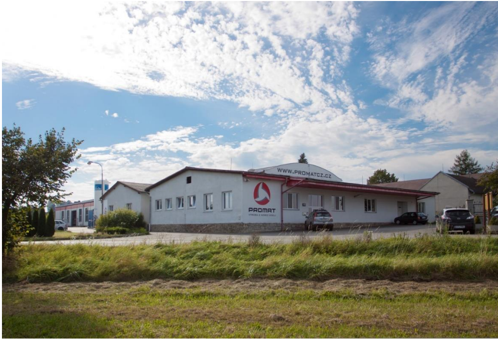
Obrázek 10: Pohled na budovu firmy Promat
