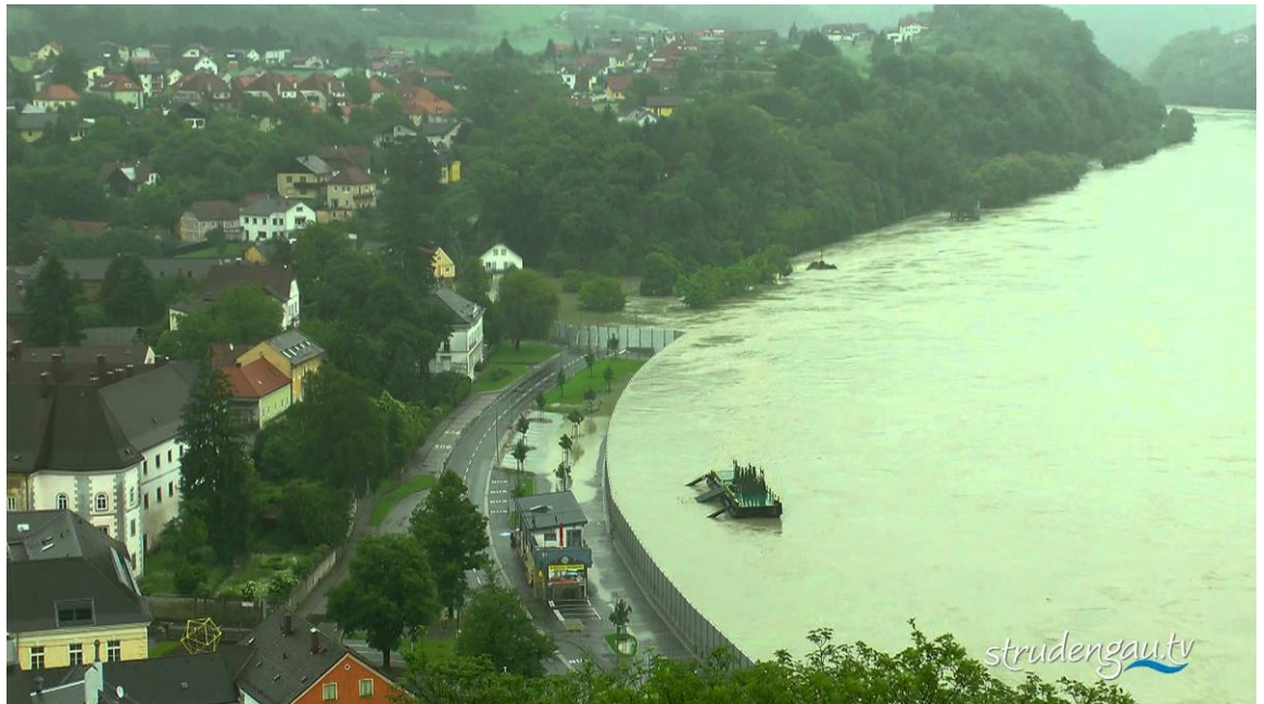
Obr. 1 Příklad mobilní protipovodňové stěny z lehkých slitin bránící rozvodněné Dunaji v zaplavení Rakouského města Grein. (strudengau.tv, 2013)
