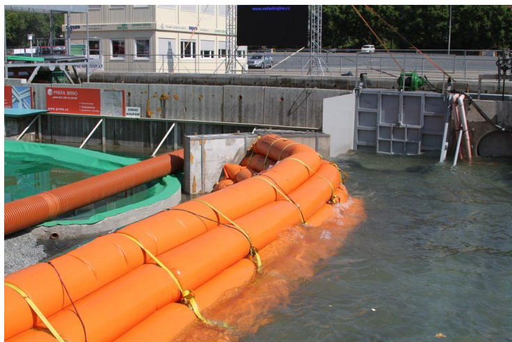
Obr. 12 Finální podoba čtyřvrstvé hráze zatížená náparem vody. (International Flood Control, 2014)
