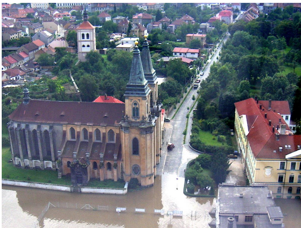
Obr. 21 Pohled na zatopené gymnasium (vpravo) a kostel Narození Pany Marie v Roudnici nad Labem (vlevo). (Anonym, 2002)
