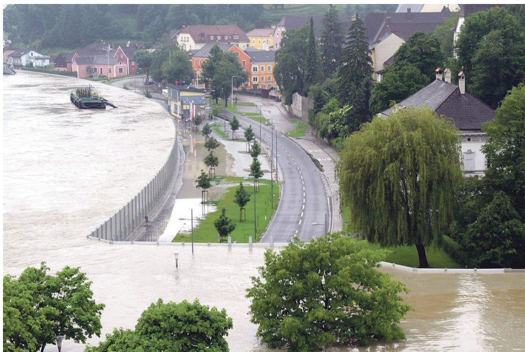
Obr. 13 Systém svislých stěn z lehkých slitin chránící Rakouské město Grein před rozvodněnou Dunají. (strudengau.tv, 2013)
