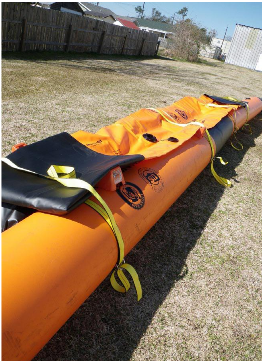
Obr. 9 Pokládání druhé vrstvy tubusů s jasně patrnými spojovacími popruhy a plastovými klíny, pro omezení pohybu při napouštění. (Johny Servis, 2009)
