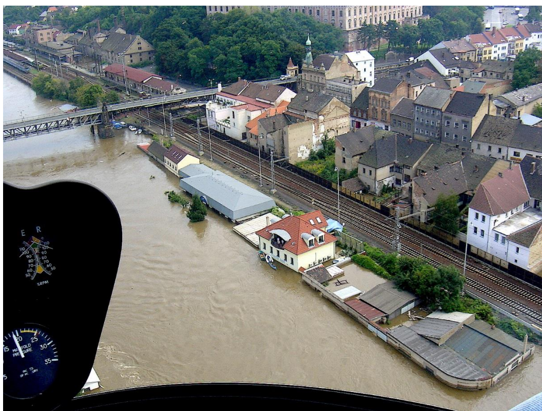
Obr. 22 Povodeň 2002 V Roudnici nad Labem. Na obrázku jsou budovy patřící především státnímu podniku Povodí Labe. (Anonym, 2002)
