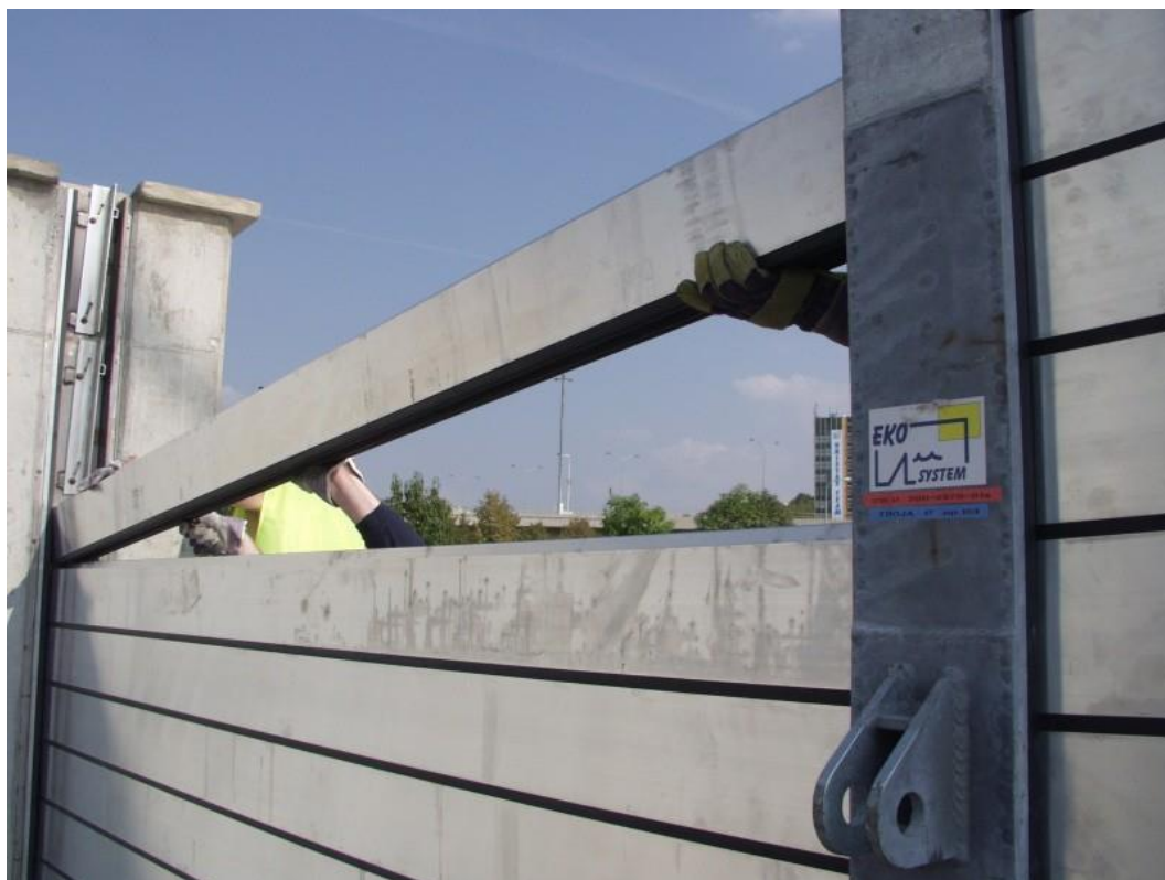
Obr. 16 Vkládání jednotlivých hradiel mezi slupici a boční vedení. (Eko-system, 2010)
