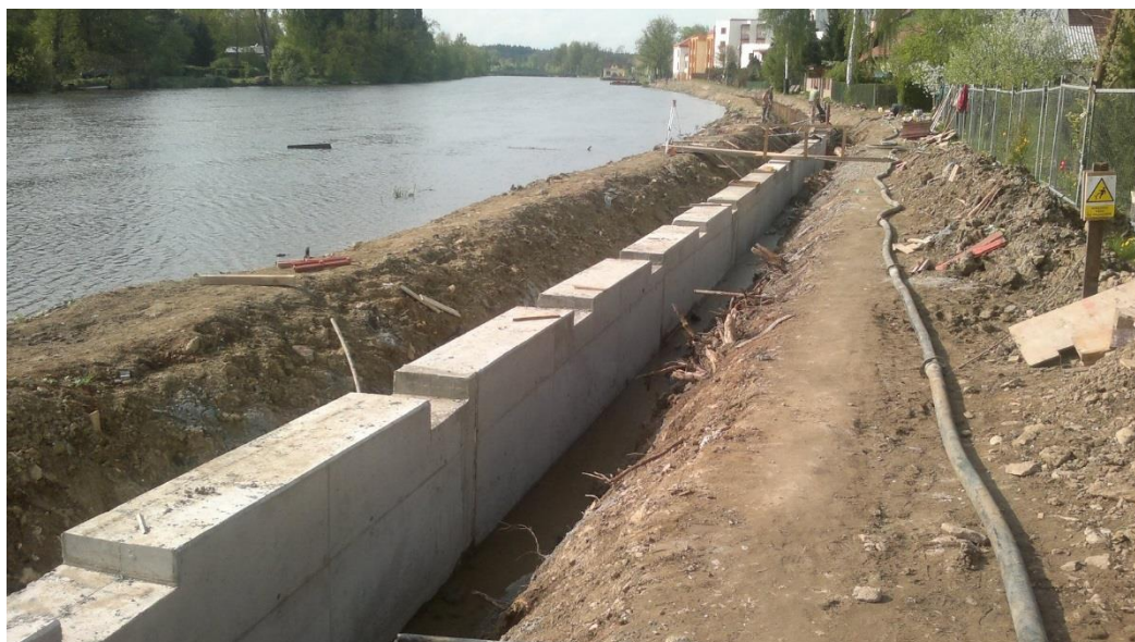
Obr. 15 Podzemní část připravované protipovodňové zdi. (anonym, 2013)
