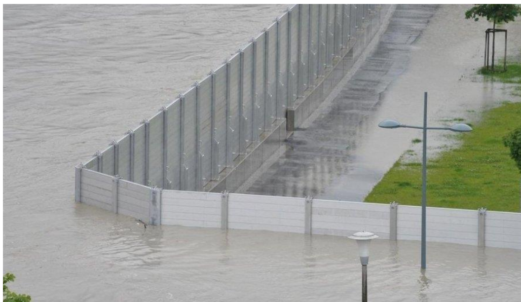
Obr. 19 Protipovodňová stěna u Rakouského města Grein, s jen minimálními průsaky, chránící před zvýšenou hladinou řeky Dunaj. (strudengau.tv, 2013)
