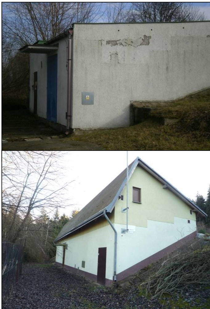
Obr. 4 – Vzhled stavu objektu před uskutečněnou rekonstrukcí (obrázek nahoře) a po uskutečněné rekonstrukci (obrázek dole) ©foto Stanislav Říha
