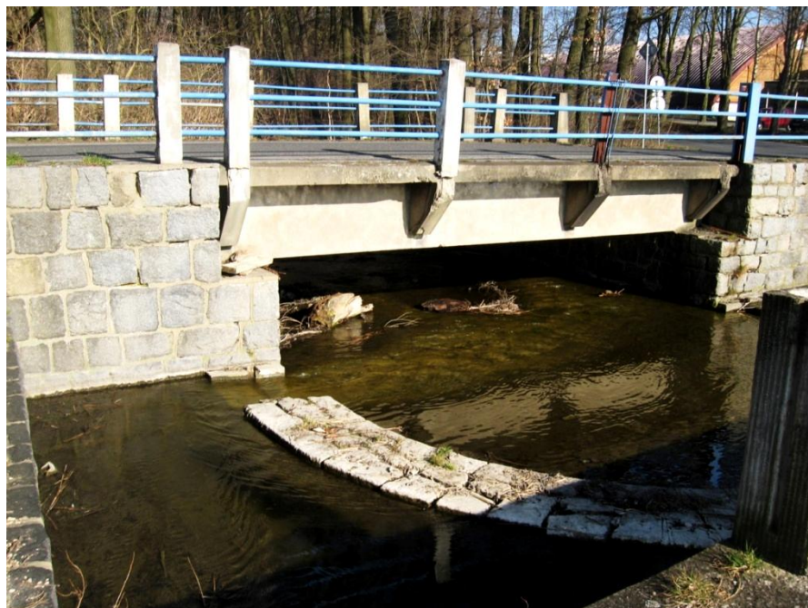
Obrázek 6: Bezpečnostní přeliv s přemostěním místní komunikace
