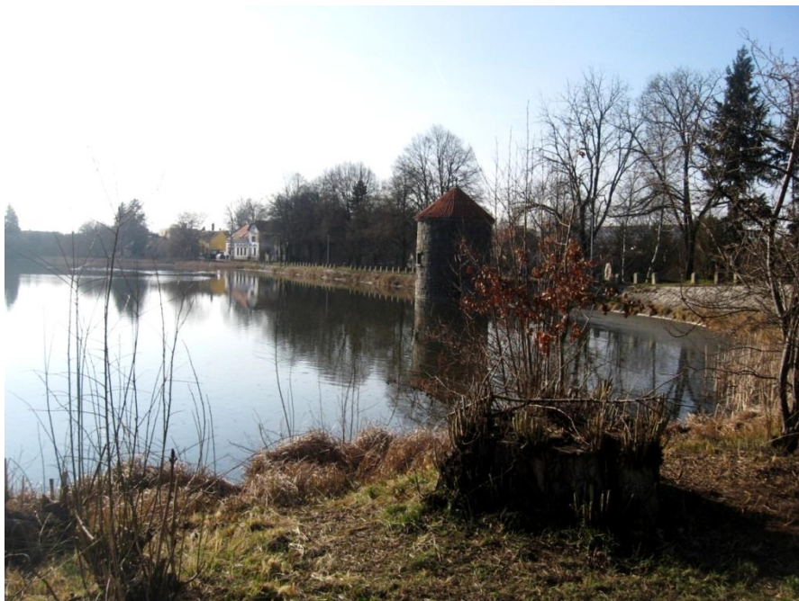
Obrázek 7: Zděný objekt se spodní výpustí
