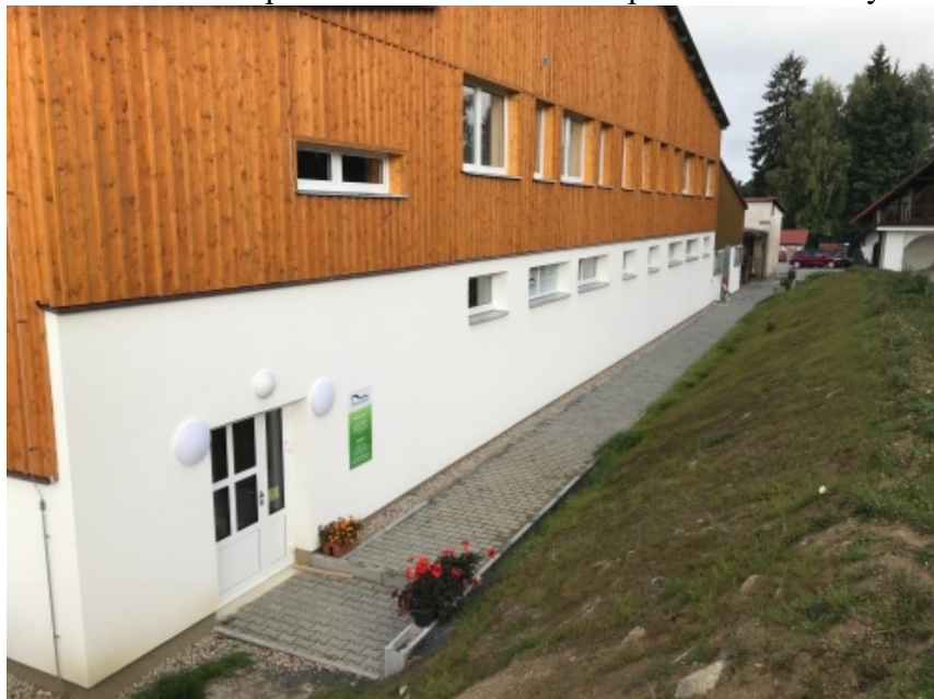
Obrázek 1: Nově postavená budova určena pro teoretickou výuku
