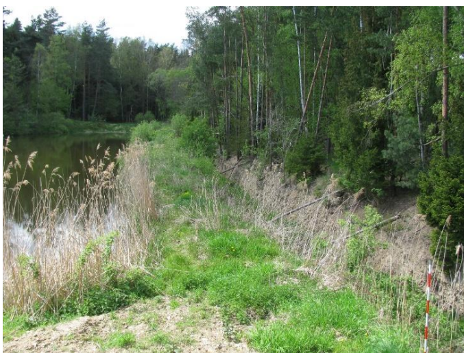
Foto 18:23 Eroze. Hráz rybníka Felix II mezi rybníkem a obtokovou strouhou. (Foto Václav Kahuda 2018).
