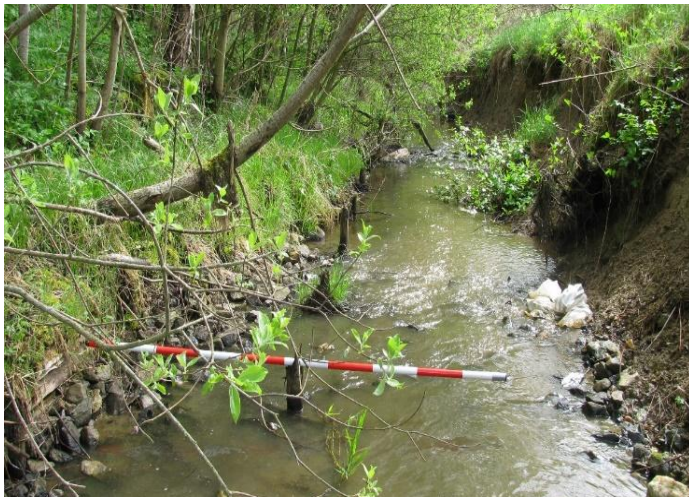
Foto 22: Degradující opevnění koryta a dna tzv. oplůtky, výrazná eroze vysokého břehu. (Foto Václav Kahuda 2015).
