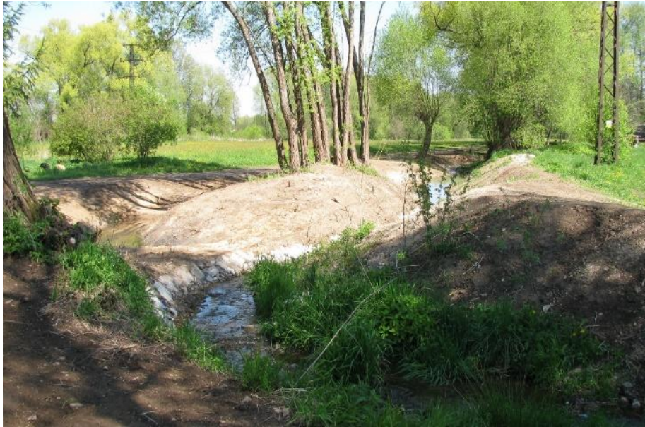
Foto 28: Revitalizace koryta drobného vodního toku – Vidov. (Foto Václav Kahuda 2018).
