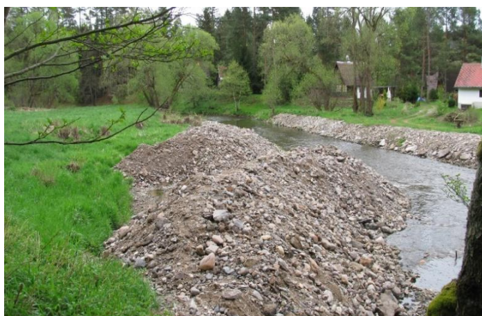
Foto 31: Materiál pro doplnění do konstrukce balvanitých skluzů. (Foto Václav Kahuda 2015).
