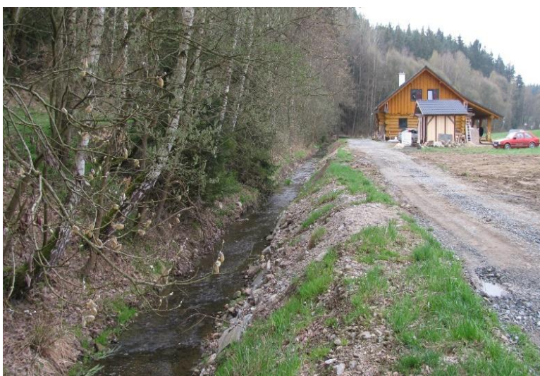
Foto 13: Rodinný dům v trase původního přirozeného koryta vodního toku. Upravené koryto po opravě břehových nátrží na pravém břehu. (Foto Václav Kahuda 2016).
