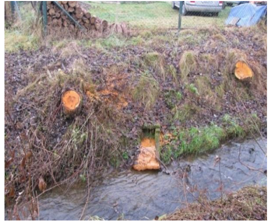
Foto 1 a 2: Vyústění drenážního systému do upraveného koryta vodního toku (Foto Václav Kahuda 2017).
