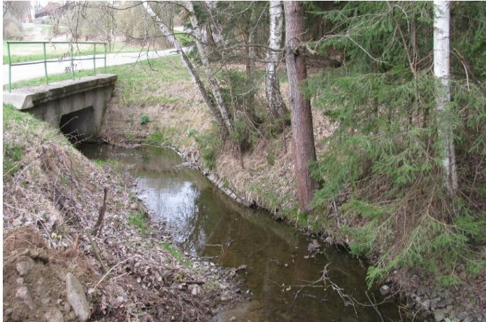
Foto 14: Zhloubené a nevhodně nasměrované koryto v prostoru silničního mostku. (Foto Václav Kahuda 2016).
