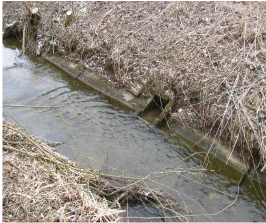
Foto 1 a 2: Vyústění drenážního systému do upraveného koryta vodního toku (Foto Václav Kahuda 2017).
