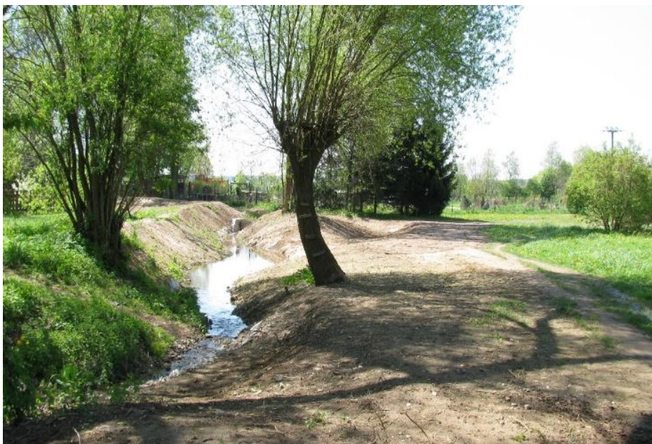
Foto 29: Revitalizace koryta drobného vodního toku – Vidov. (Foto Václav Kahuda 2018).
