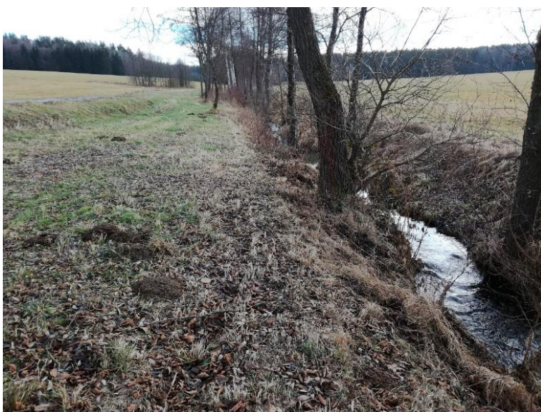
Foto 9: Revitalizace upraveného koryta Dobečovského potoka realizovaná v roce 1997 dle projektu z roku 1992 – aktuální stav únor 2019. (Foto Václav Kahuda 2019).
