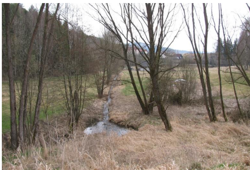
Foto 30: Horní úsek vodního toku k revitalizaci. Tůň pod hrází rybníka bude zachována, stabilizována, směrem doprava bude pokračovat revitalizované koryto. (Foto Václav Kahuda 2019).
