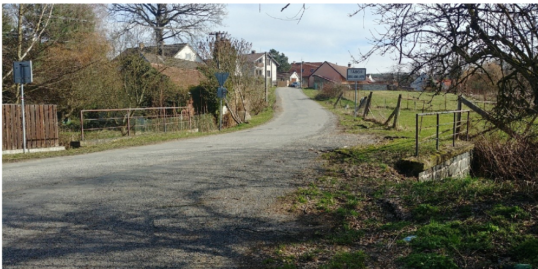
obr. 23.3: pohled na trasu stoky A před zaústěním do ČOV, severovýchodní pohled, zdroj: autor
