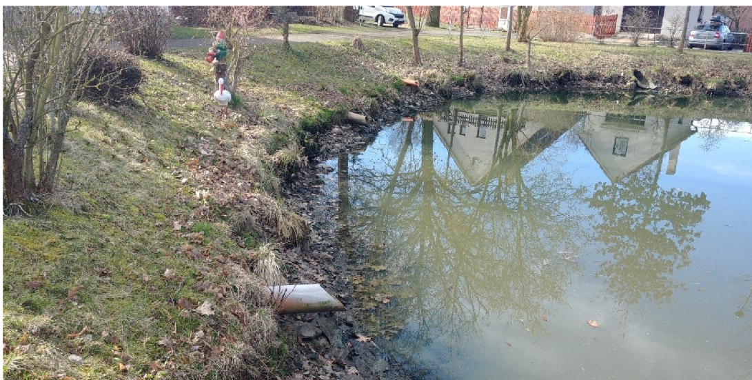
obr. 23.6: pohled na současné vyústění stávající kanalizace do návěsního rybníku, zdroj: autor
