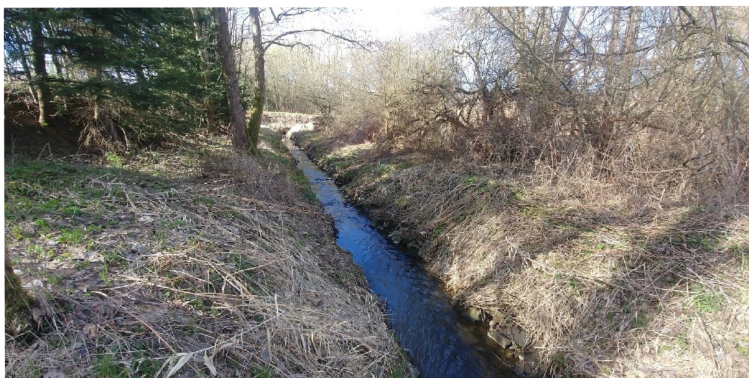
obr. 23.2: pohled ve směru toku na bezejmenný potok do kterého bude zaústěn výustní objekt ČOV, zdroj: autor
