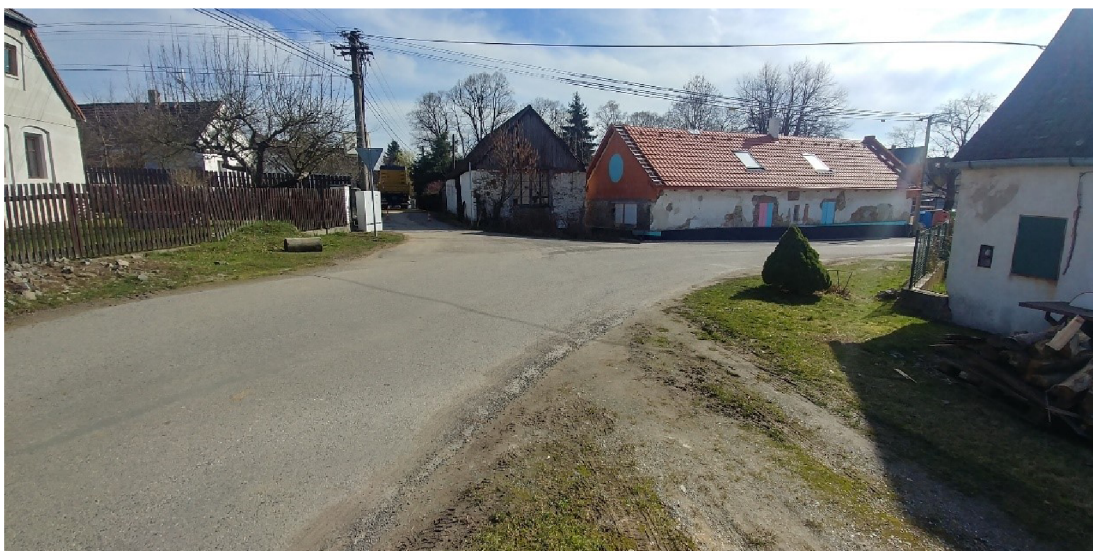
obr. 23.4: pohled na místo budoucího zaústění stoky B do stoky A, jihovýchodní pohled, zdroj: autor
