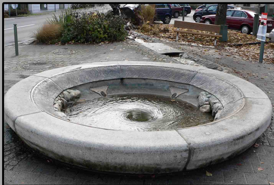
2006-10-28. Zwettl, Rakousko. Kruhový vodní vír, kam se voda sbíhá z přilehlých kanálků. Voda se zde velmi dynamicky točí a prvek je značně zajímavý. Tento princip je jednoduchý a jeho údržba není finančně náročná, proto určitě stojí za povšimnutí.
