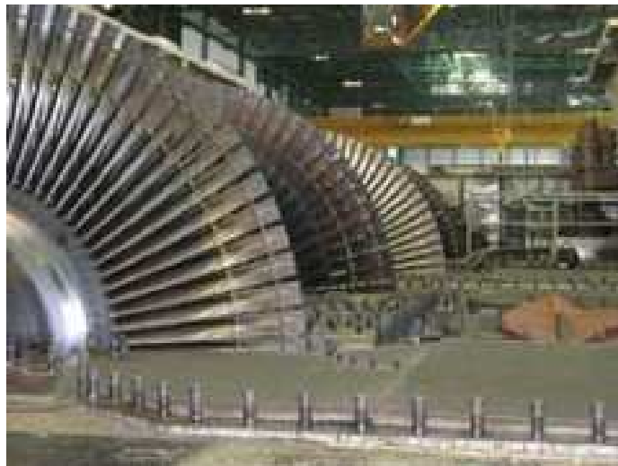
6.4. Oprava parní turbíny[39]
