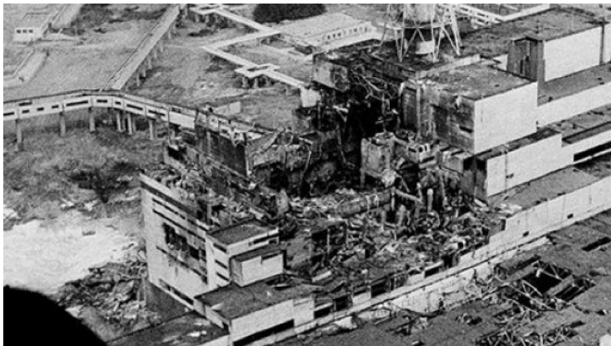
4.1. Jaderná elektrárna Černobyl po havárii[33]
