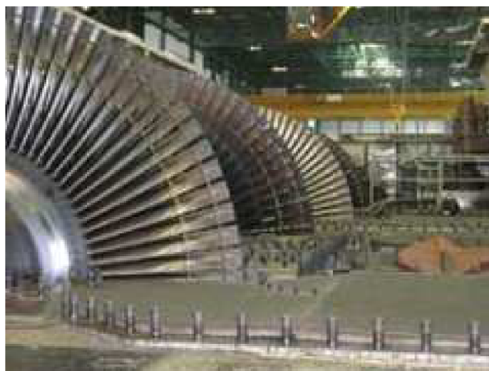
6.4. Oprava parní turbíny[39]
