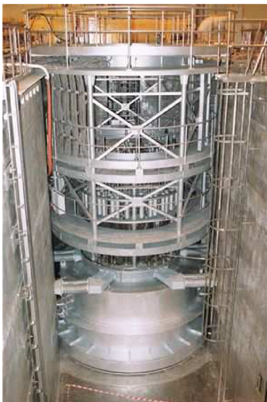
6.3. Tlaková nádoba reaktoru[38]
