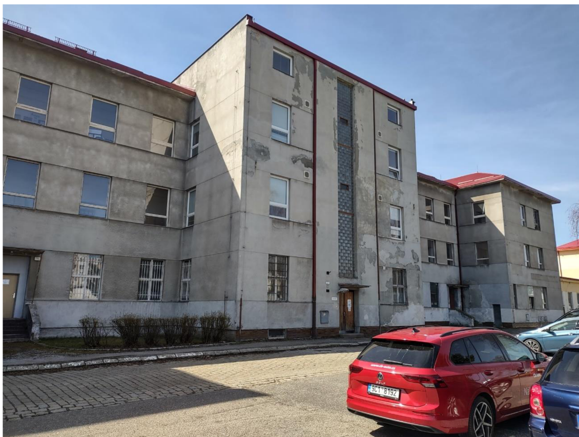
Obrázek 20: V části budovy sídlí mechanizovaná rota AZ, 42. mechanizovaného praporu Zdroj: Vlastní fotografie
