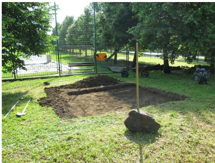
Obrázek 11 Ukázka výkopu základů ( Editor webu, 2013 )
