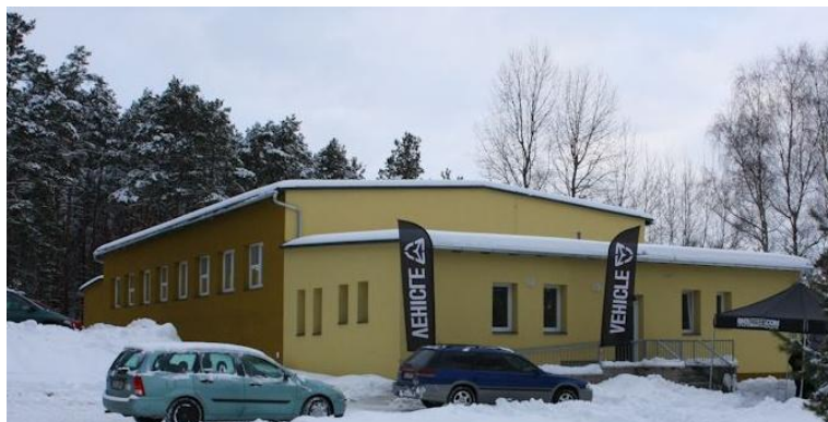
Obrázek 18. Hala po dokončené rekonstrukci
