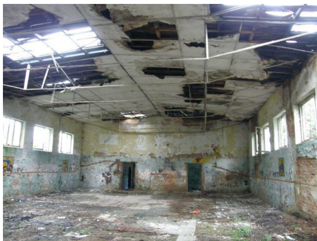
Obrázek 17. Stav haly před rekonstrukcí
