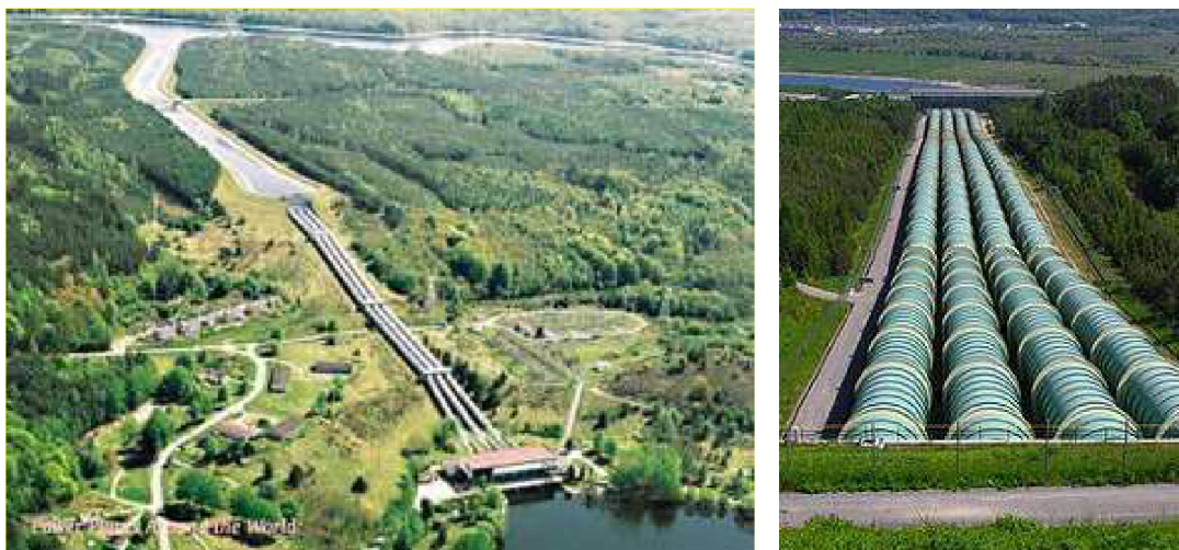
Obr. 5 Pohled na povrchové přivaděče PVE Zydowo (vlevo) a Żarnowiec (vpravo)
