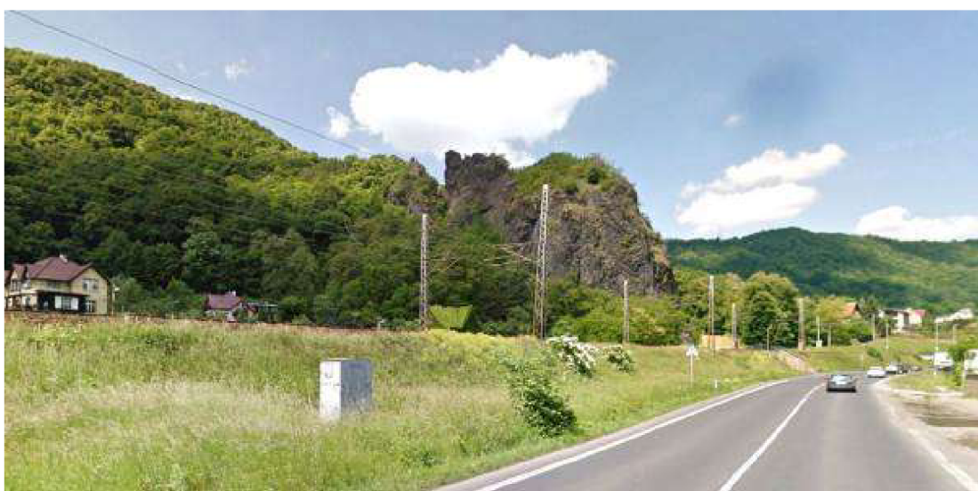
Obr. 9 Výchoz čediče v patě levého svahu
