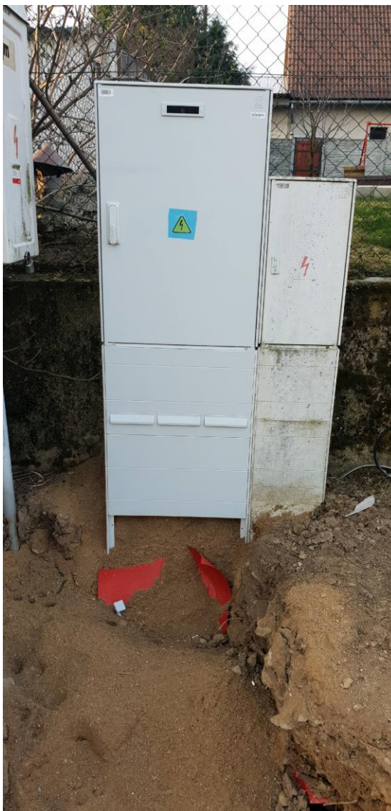
Obrázek 41 - Uložení kabelového vedení do písku s výstražnou fólií
