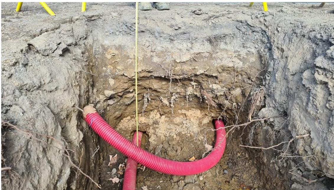
Obrázek 30 – Protlak pod komunikací
