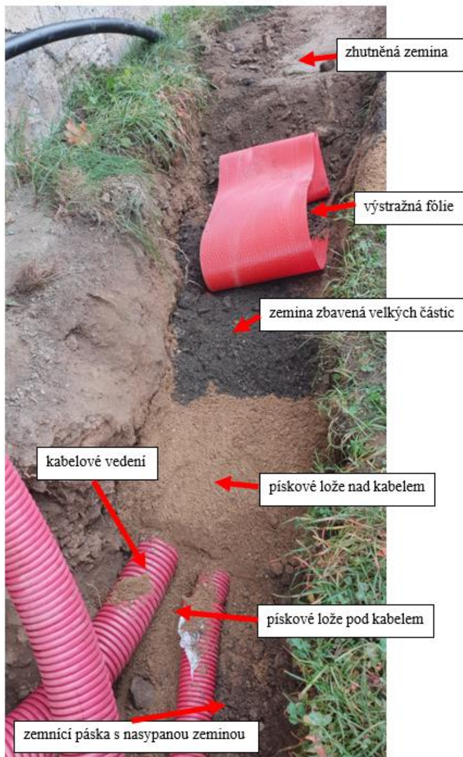
Obrázek 29 – Skladba vrstev ve výkopu
