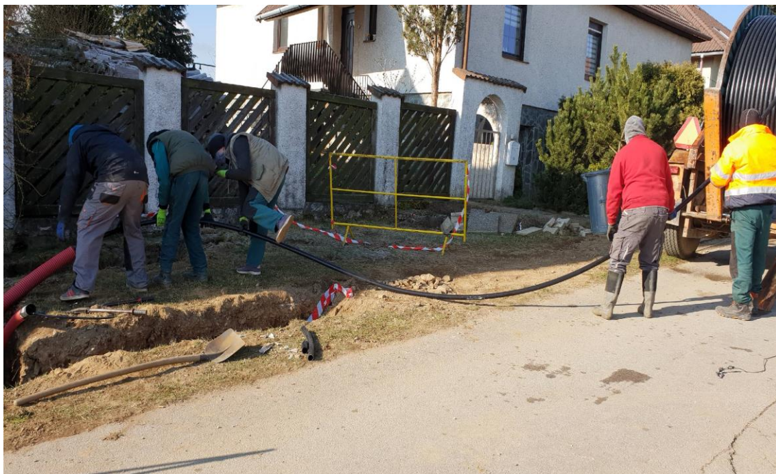
Obrázek 48 - Zasouvání kabelu do arotu z kabelového bubnu
