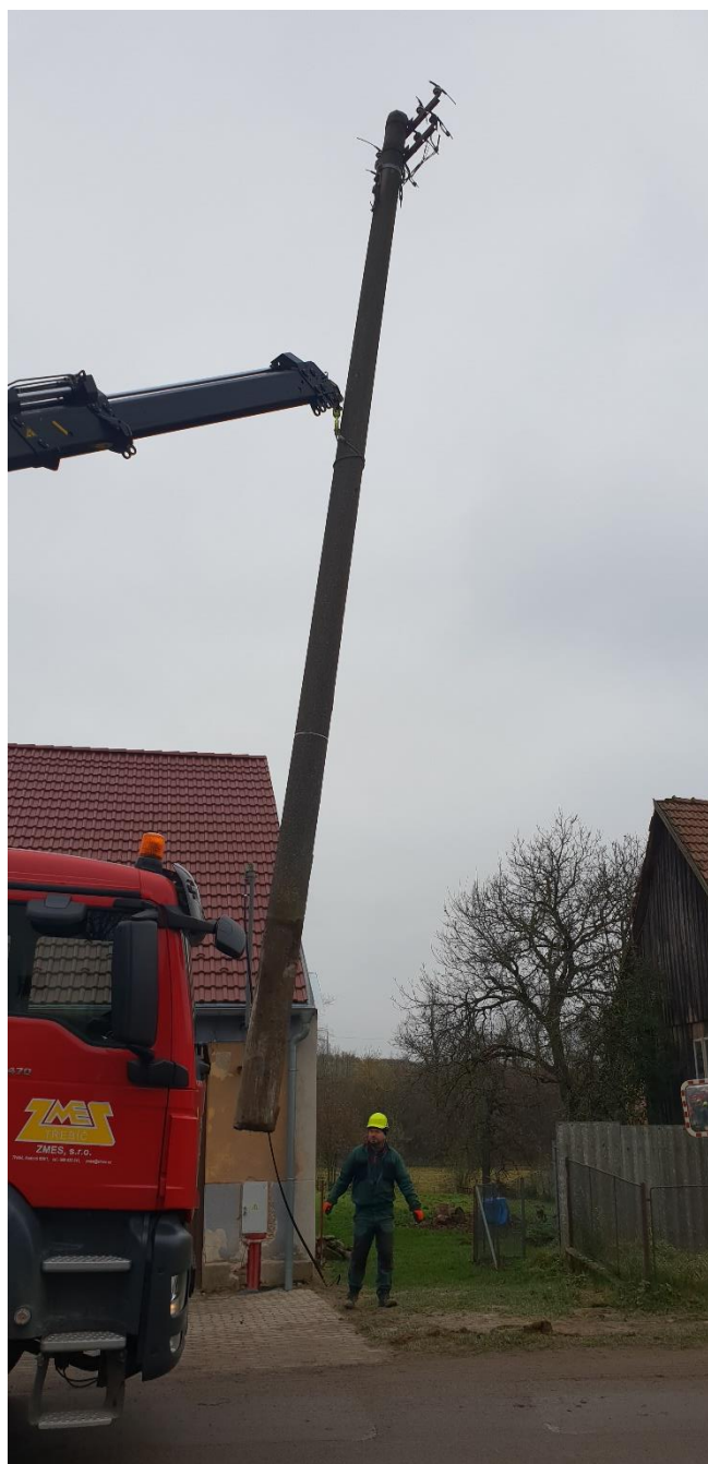
Obrázek 57 – Vytahování sloupu ze země
