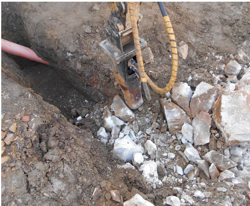
Obrázek 10 – Odstraňování velkých kamenů hydraulickým kladivem
