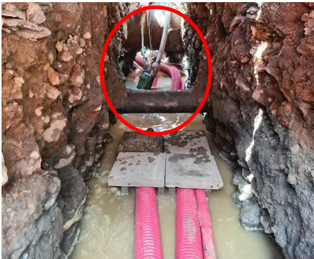
Obrázek 8 – Odčerpání spodní vody čerpadlem
