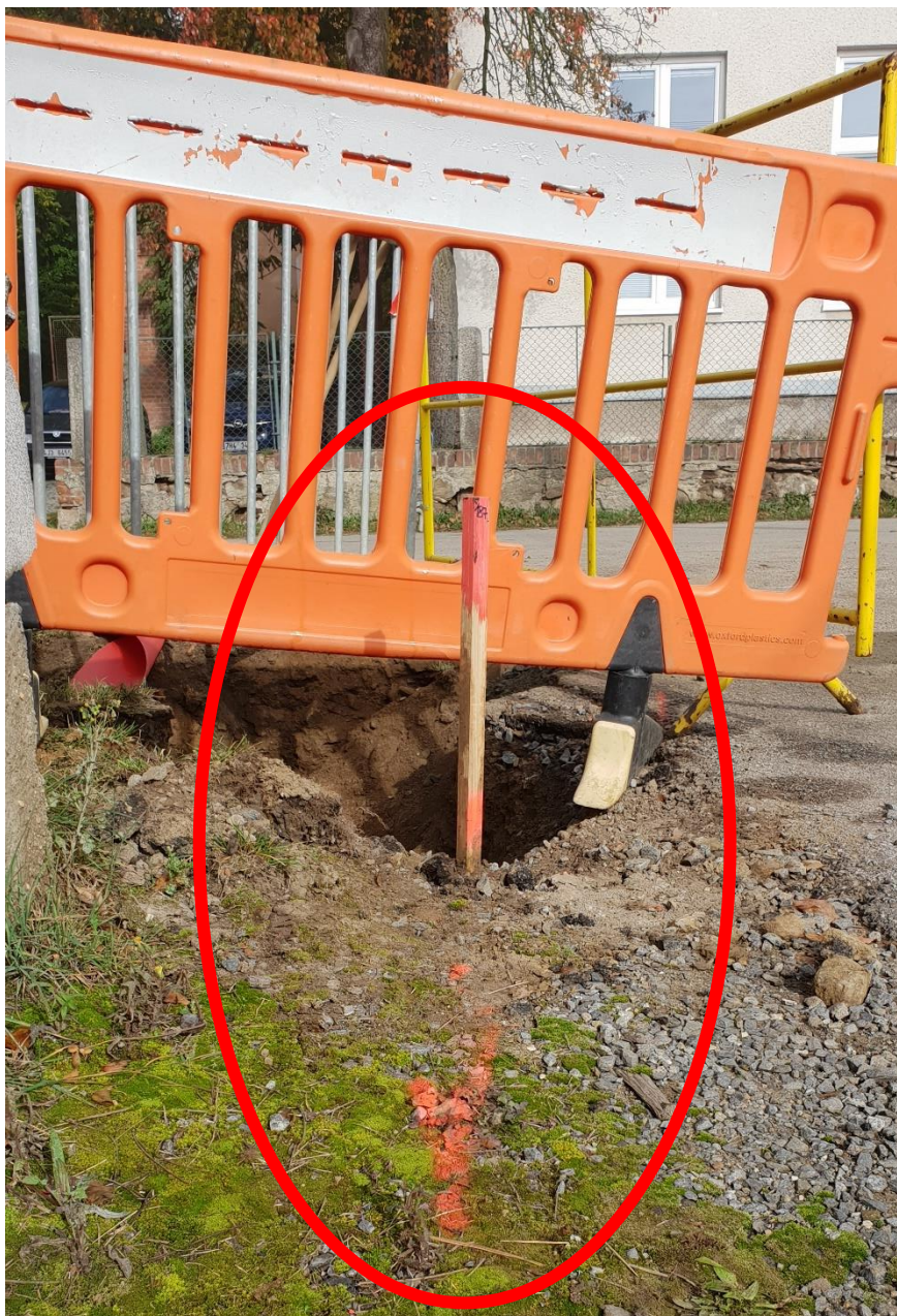
Obrázek 2 – Vyznačení vedení kabelu telefonu
