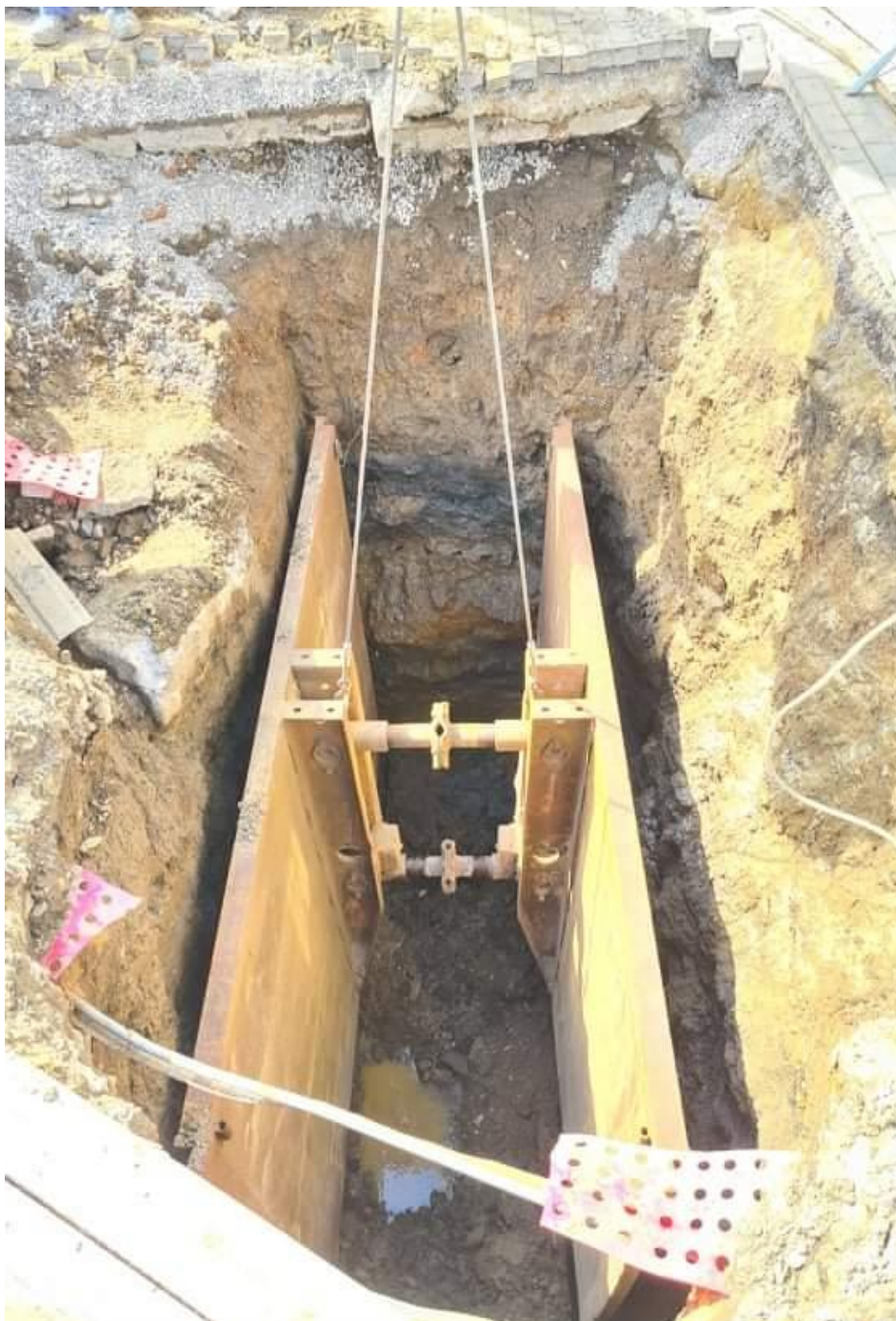
Obrázek 6 – Jáma zabezpečená pažením
