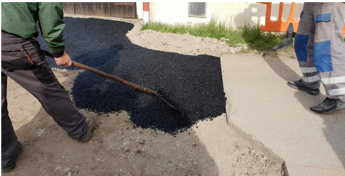
Obrázek 36 – Napojení nového asfaltu na původní
