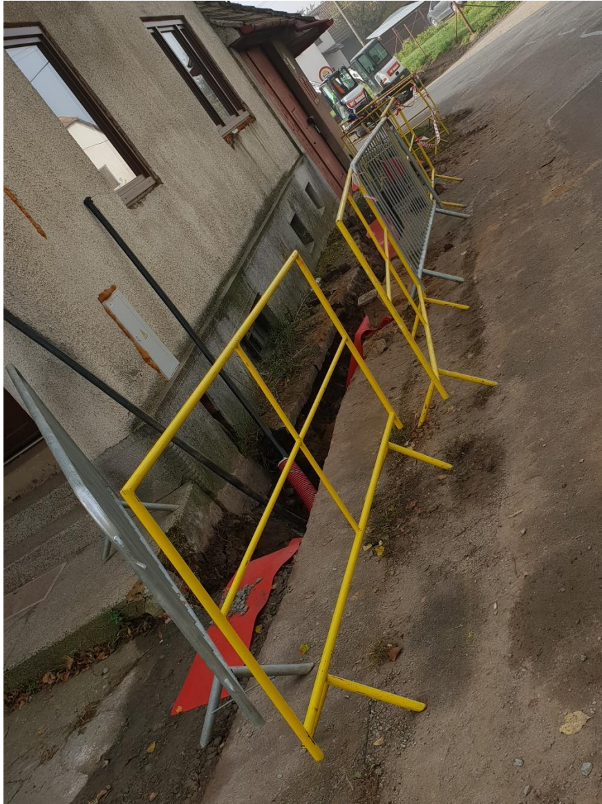
Obrázek 3 – Zajištění výkopu ochrannými zábradlí
