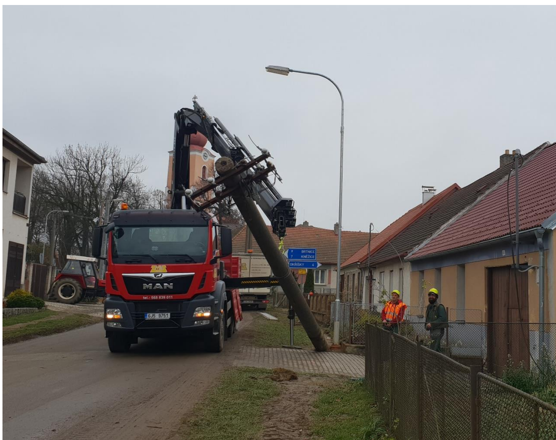
Obrázek 58 – Pokládání vytaženého sloupu
