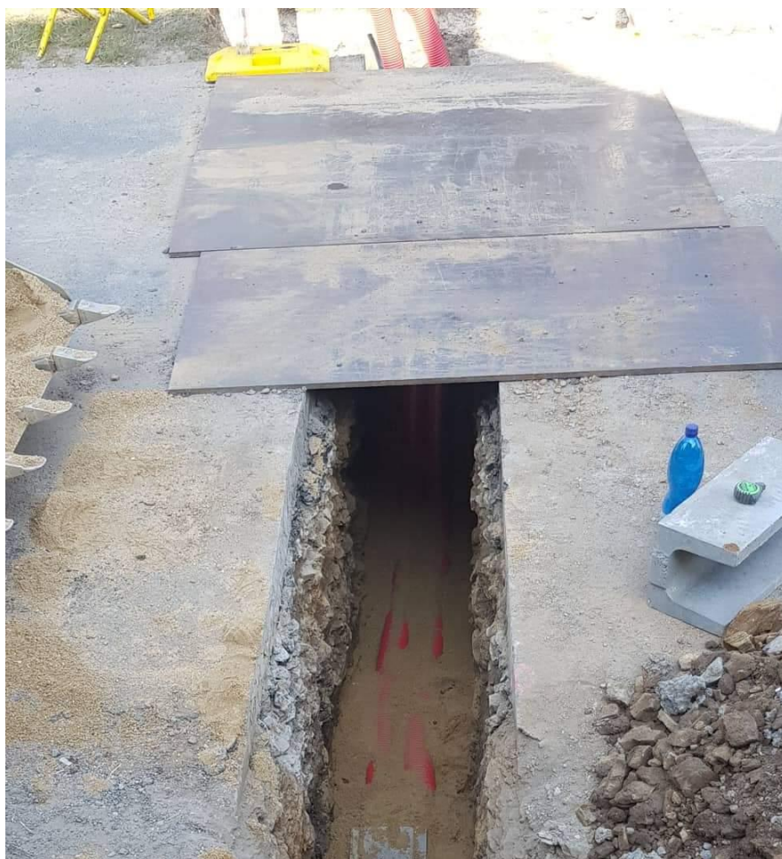
Obrázek 5 – Dočasný přejezd přes komunikaci
