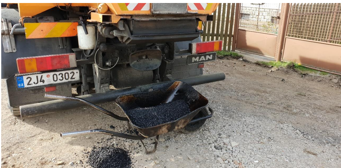
Obrázek 35 – Zpětné zaasfaltování komunikace
