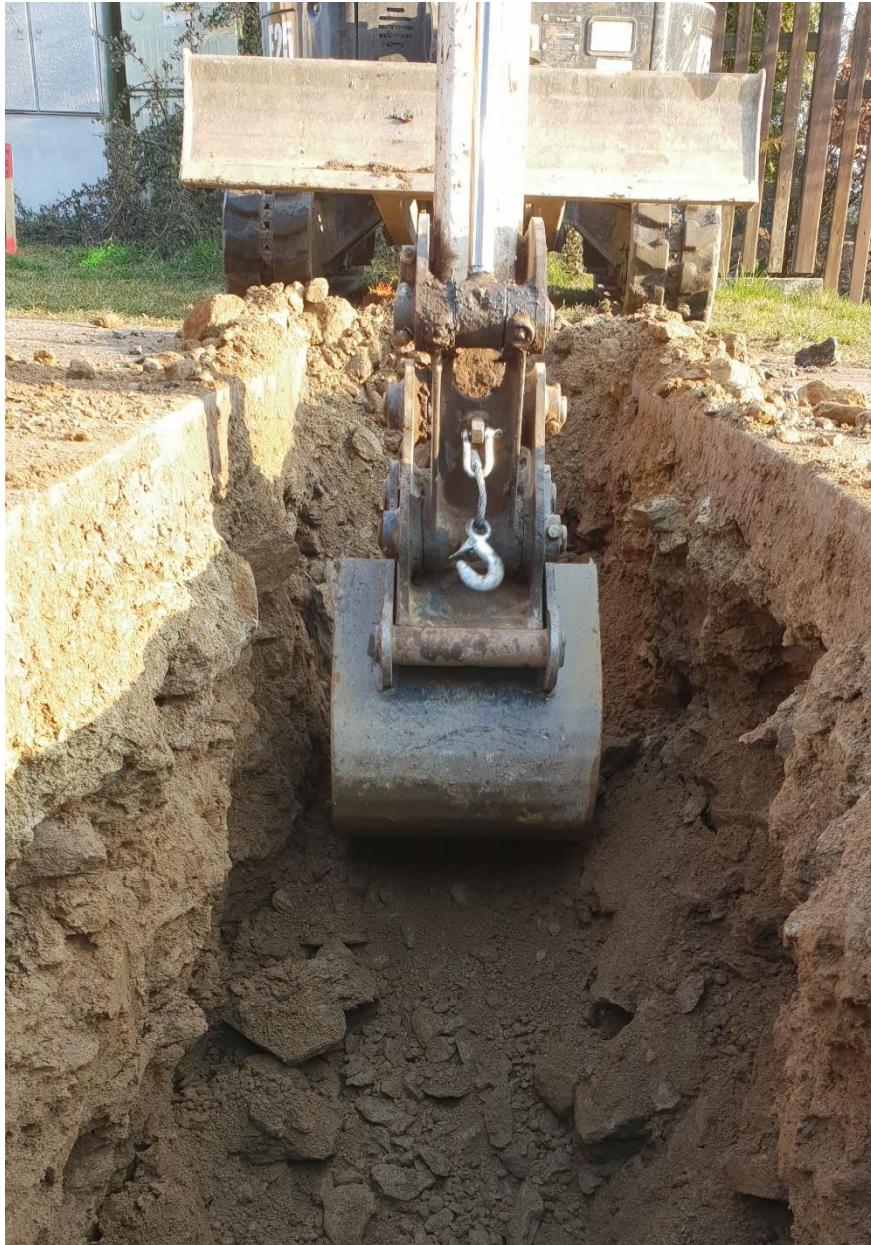
Obrázek 11 – Hloubení jámy pomocí stroje
