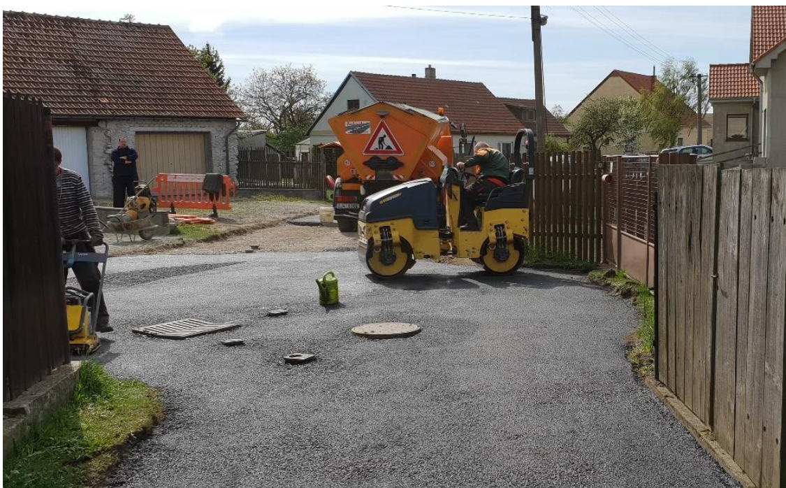
Obrázek 37 – Válcování asfaltu
