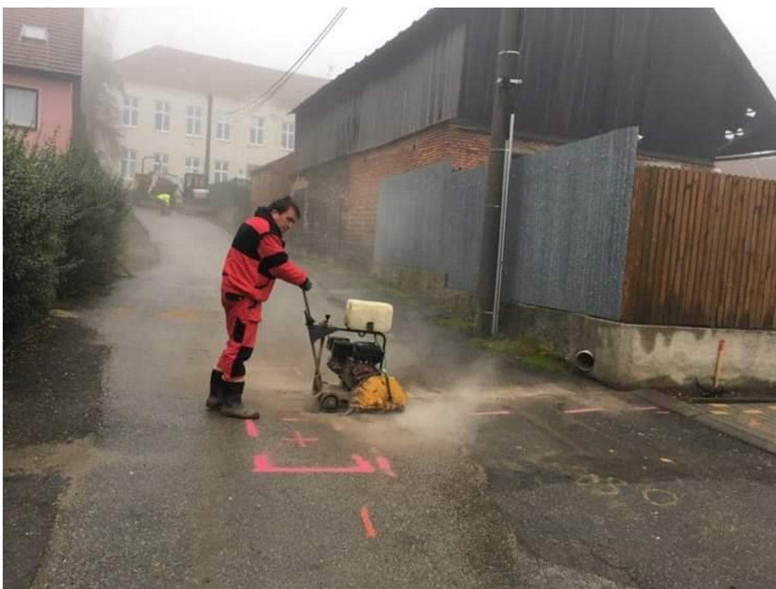
Obrázek 31 – Řezání asfaltu pro provedení překopu s vyznačenou trasou
