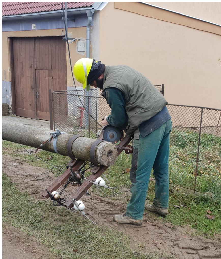
Obrázek 59 – Odříznutí kovových částic z betonového sloupu
