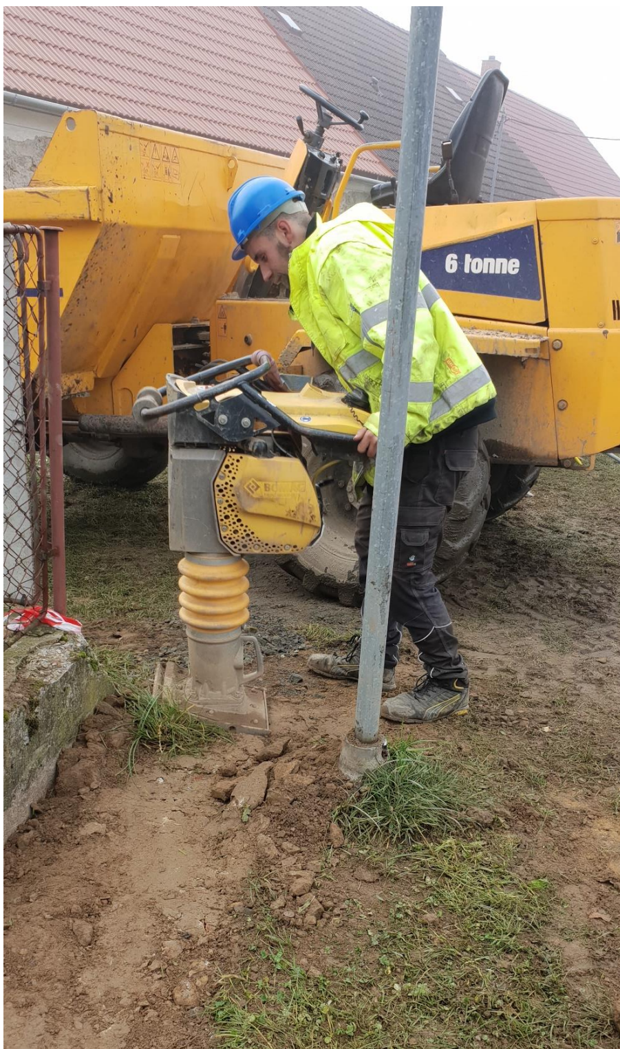
Obrázek 7 – Zhutňování zeminy vibračním pěchem
