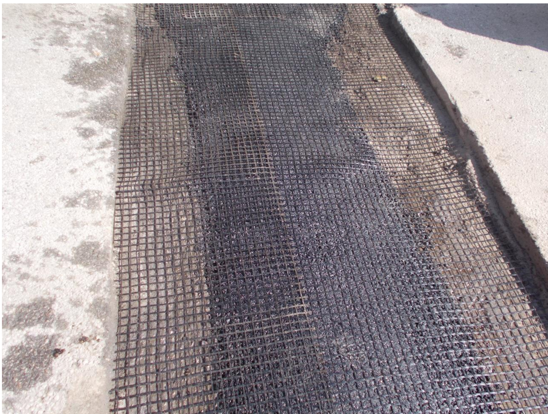
Obrázek 34 – Geomříž pro vyztužení asfaltu
