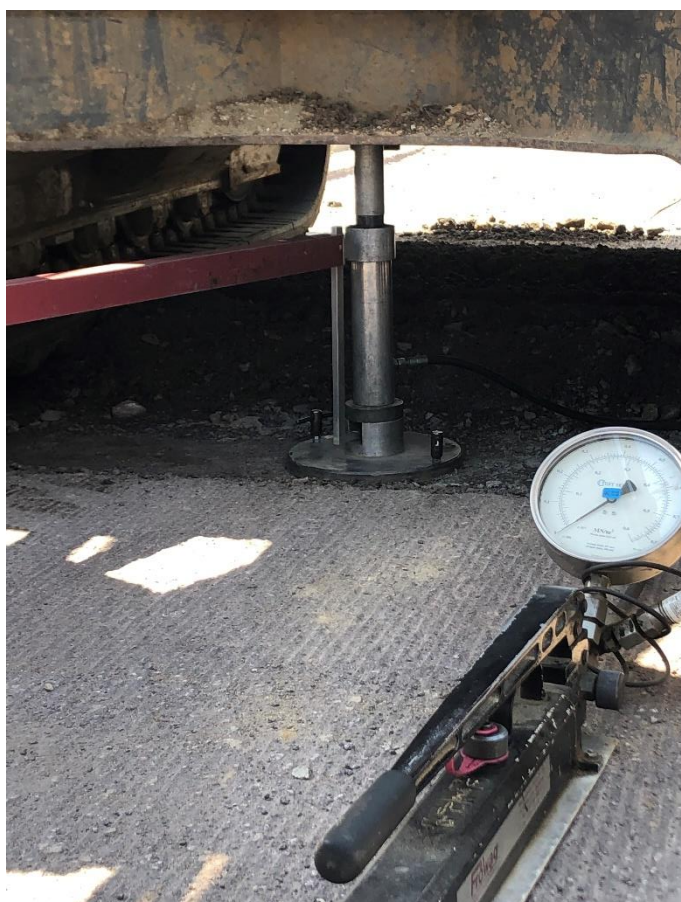
Obrázek 33 – Provádění zátěžové zkoušky
