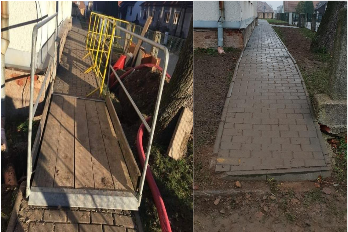
Obrázek 38 – Uvedení chodníku a okolní zeminy do původního stavu
