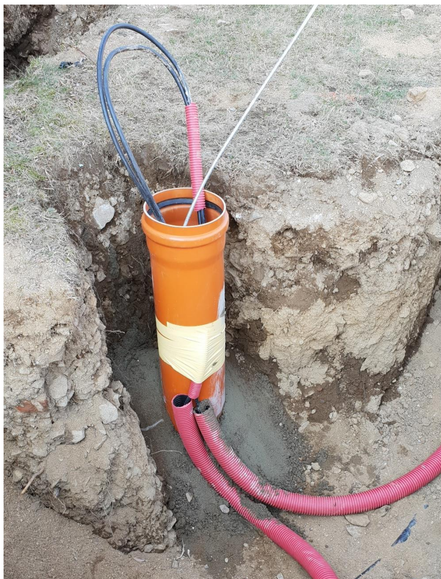
Obrázek 60 – Základ sloupu nového veřejného osvětlení
