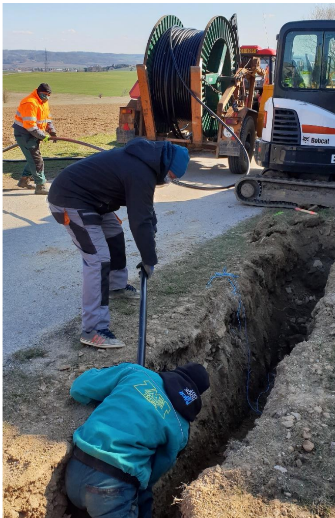
Obrázek 49 – Ruční pokládka kabelů
