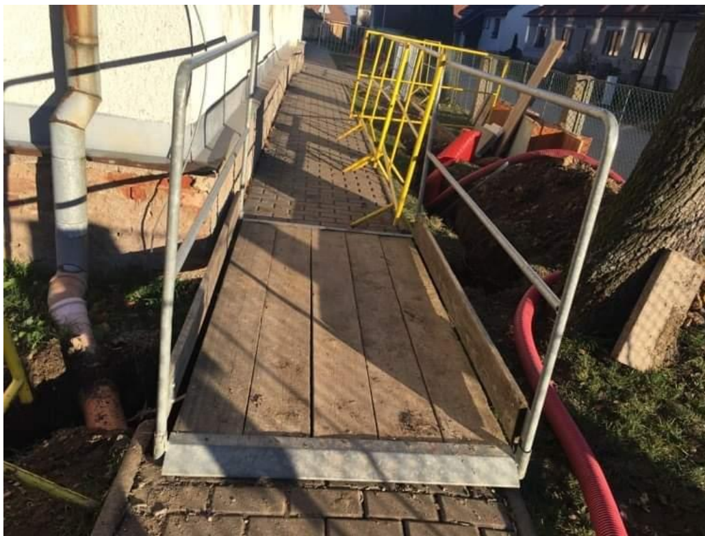
Obrázek 4 – Zajištění bezbariérového přechodu chodníku
