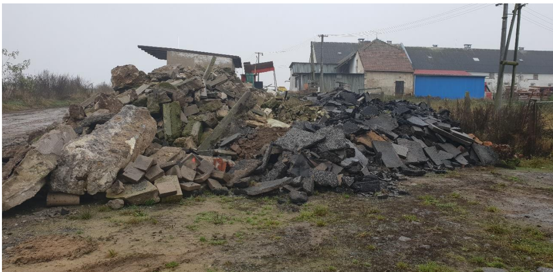
Obrázek 26 – Meziskládka betonového a asfaltového odpadu
