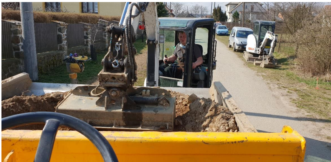
Obrázek 12 – Doprava zeminy strojně
