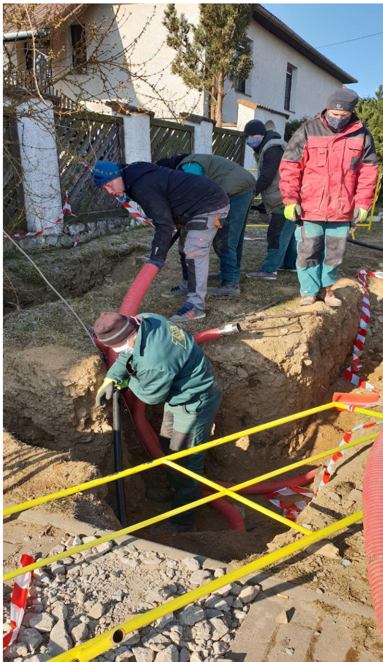
Obrázek 47 - Zasouvání kabelu do arotu
