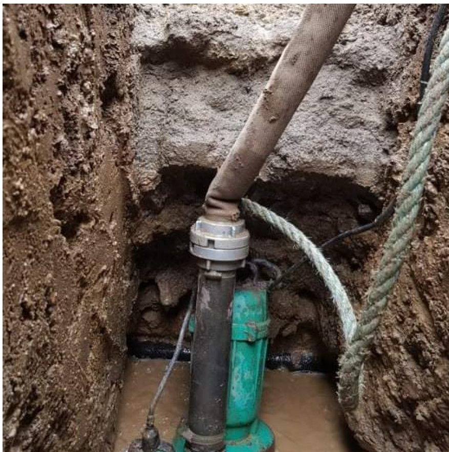
Obrázek 9 – Odčerpávání v detailu
