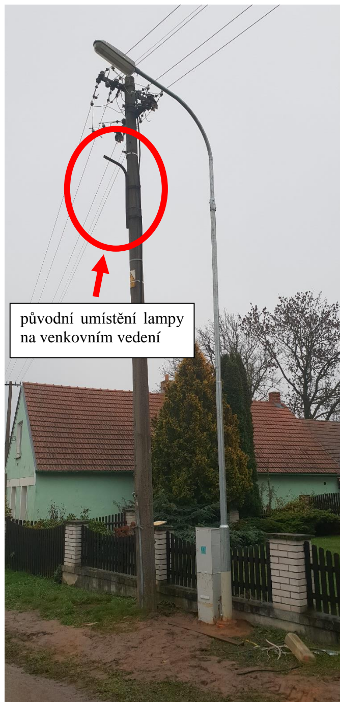
Obrázek 61 – Nové veřejné osvětlení a původní umístění lampy
