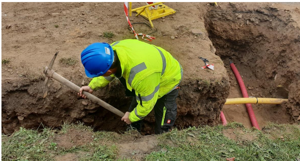
Obrázek 1 – Ruční kopání z důvodu výskytu elektrického kabelu
