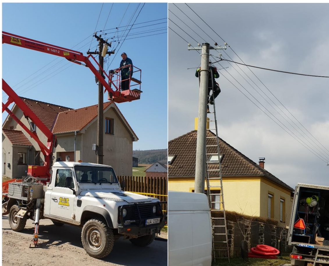
Obrázek 56 – Odšťihávání odpojeného elektrického vedení
