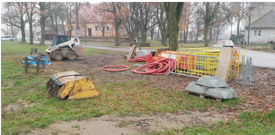
Obrázek 25 – Meziskládka stavebního materiálu uprostřed městyse
