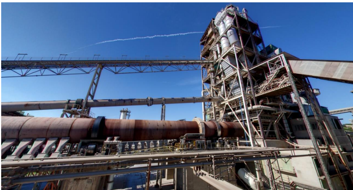
Obr. 2 – Výměníky s rotační pecí [22]
