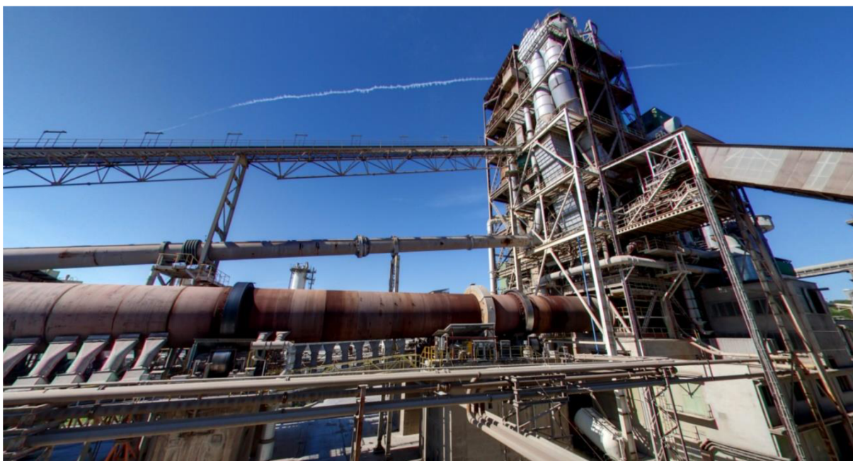
Obr. 2 – Výměníky s rotační pecí [22]
