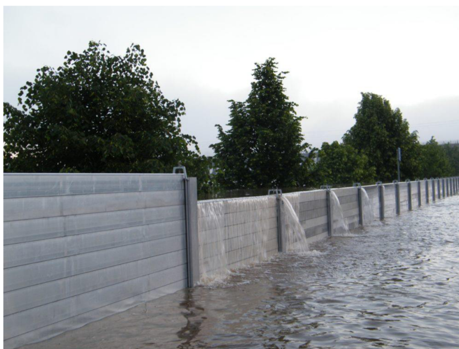
Obrázek 3: Přetékající voda přes protipovodňové zábrany v Ústí nad Labem (Foto: Hauptvogelová 2013)
