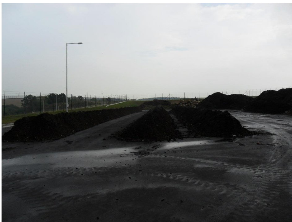
Obr. č. 8 – Zakládky na kompostárně Přerov – Žeravice (Čoček, 2016)
