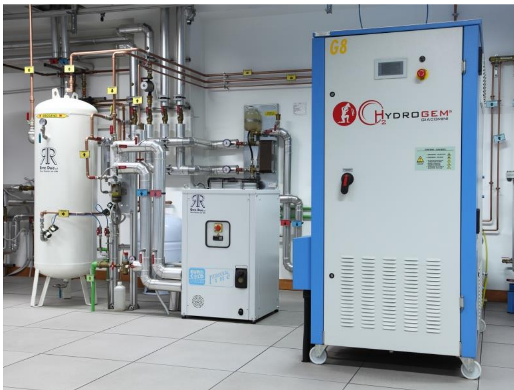
Obrázek 6: Instalace hybridního vodíkového zařízení GIACOMINI
