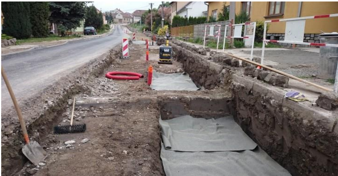
Obrázek č. 5 Během rekonstrukce kanalizace
