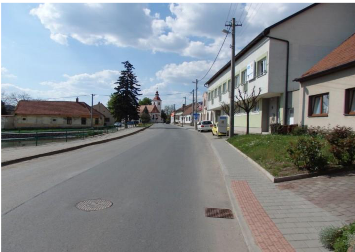
Obrázek č. 6 Po rekonstrukci
