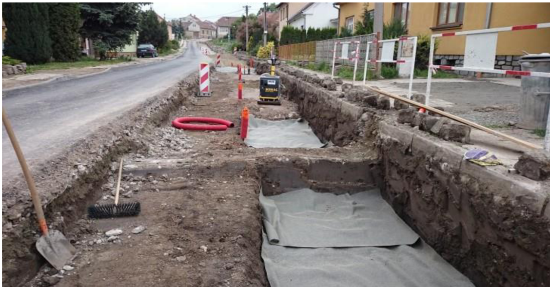
Obrázek č. 5 Během rekonstrukce kanalizace
