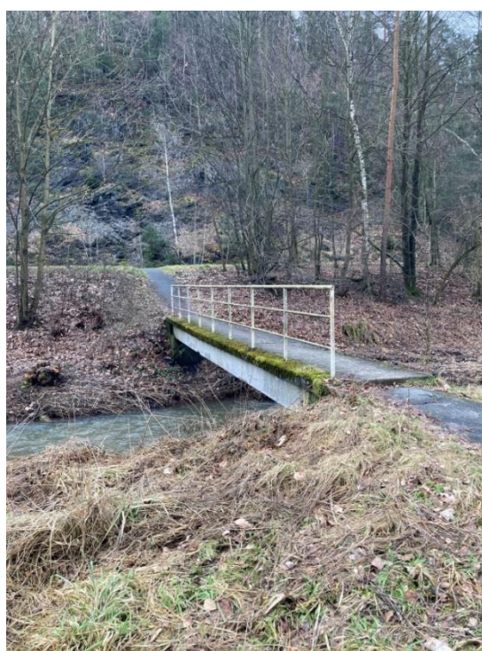
Obr.16: Most v první části řešeného úseku (Pospíšilová, 2023).
