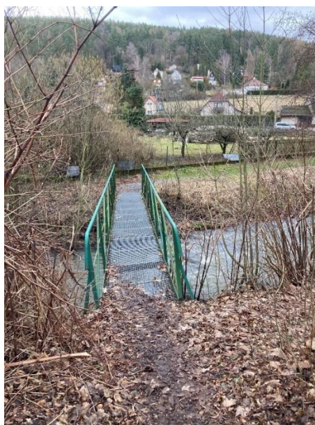
Obr. 22: Most ukončující druhou část řešeného úseku (Pospíšilová, 2023).
