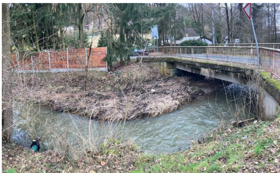
Obr. 28: Most v třetí části řešeného úseku (Pospíšilová, 2023).
