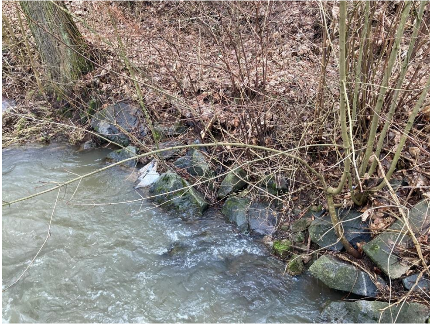
Obr. 23: Chátrající opevnění v druhé části řešeného úseku (Pospíšilová, 2023).
