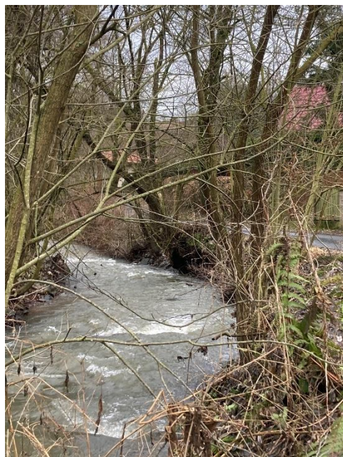
Obr. 27: Vymleté břehy podél komunikace v třetí části řešeného úseku (Pospíšilová, 2023).
