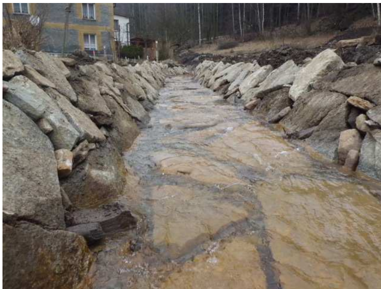
Obr. 12: Příklad realizace kamenné rovnániny (Hradištský potok u Klášterce nad Ohří) – investor Lesy České republiky s. p.
