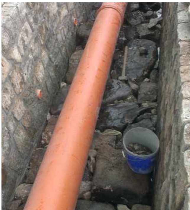
Obr. 10: Kamenný zához dna (Kozí potok – Potůčky).
