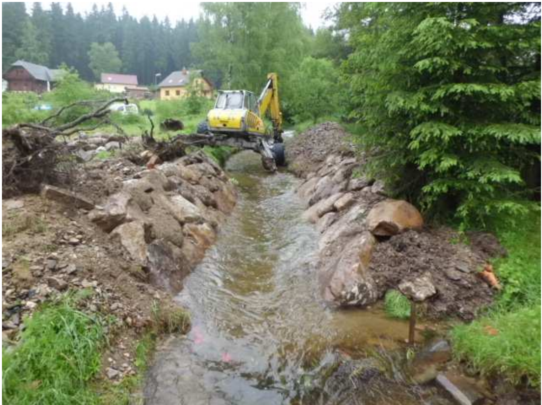
Obr. 6: Průběh úpravy břehů lomovým kamenem (Kozí potok – Potůčky).
