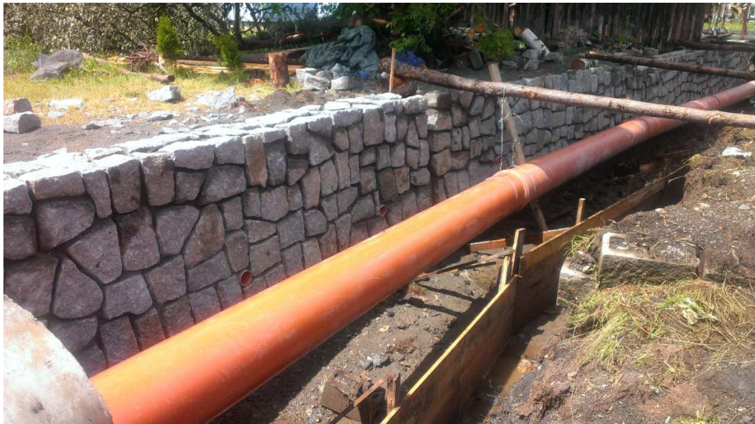
Obr. 8: Úprava toku ze soklového kamene (Kozí potok – Potůčky).
