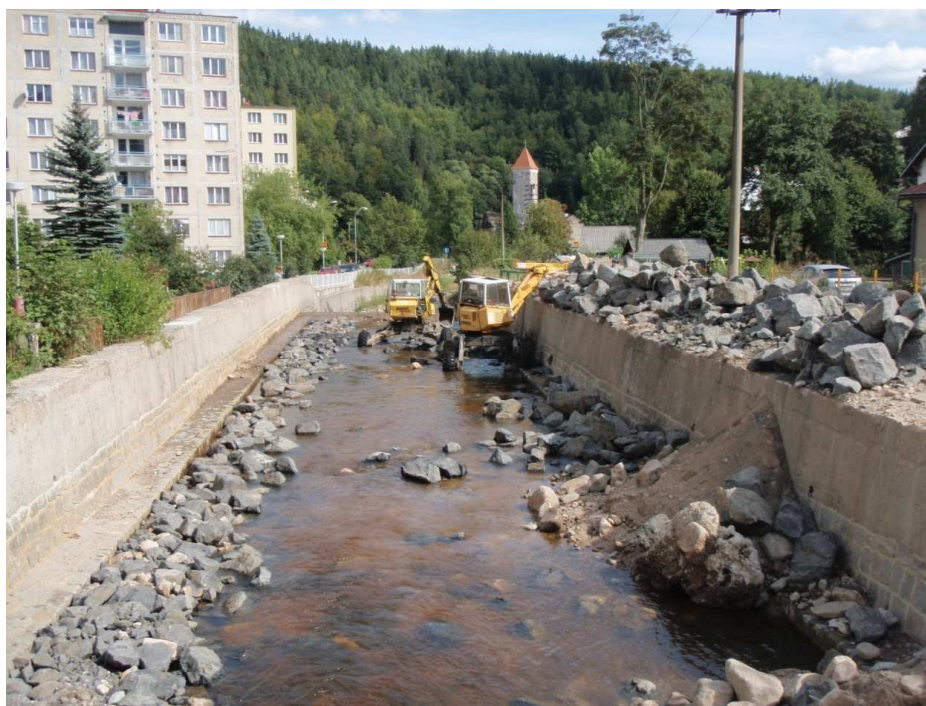
Obr. 13: Zához paty – úpravy lomovým kamenem s urovnáním líce.
