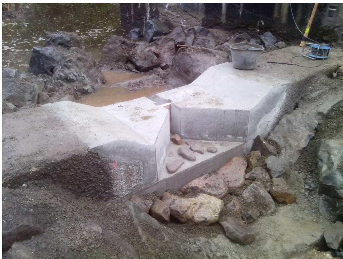
Obr. 4: VT Pramenský potok – výstavba rybního přechodu (říční km 4,23).
