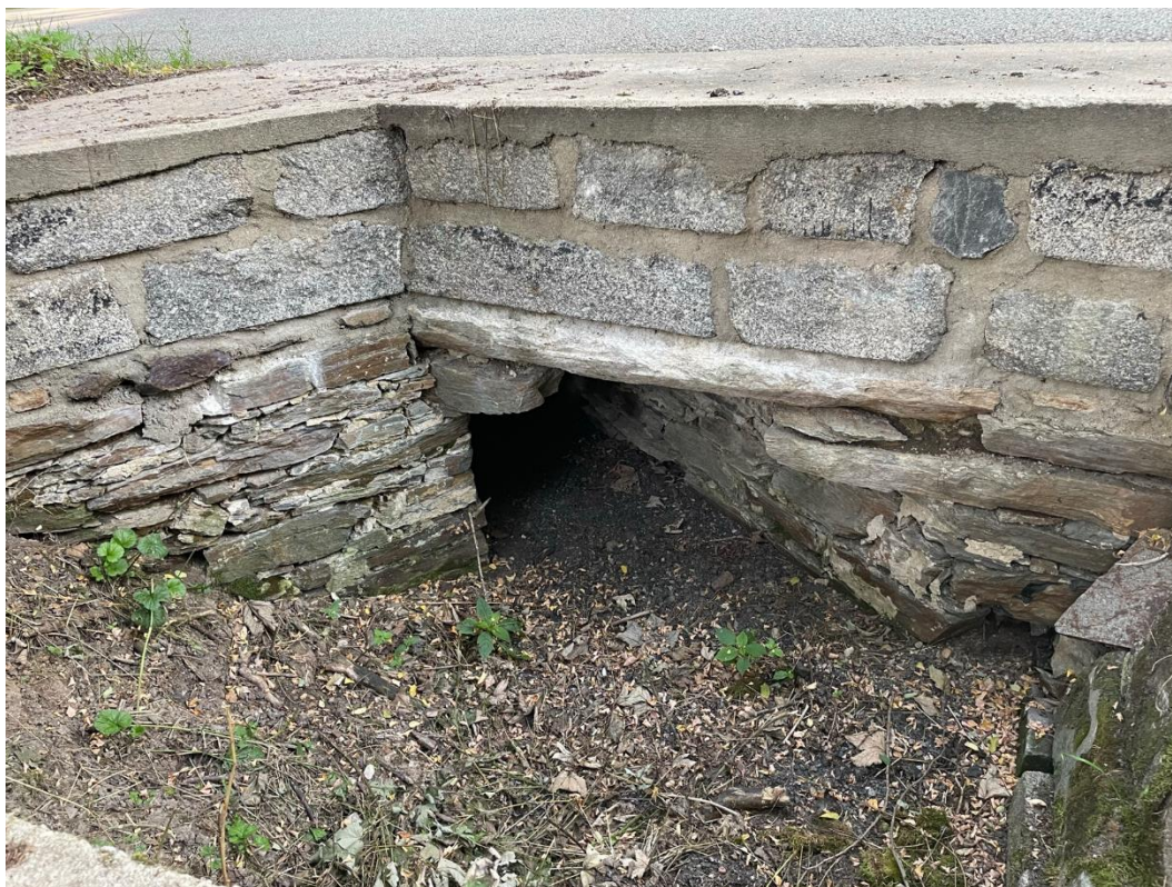
Obrázek P3 – Propustek (je na něj napojen navržený svodný průleh)
