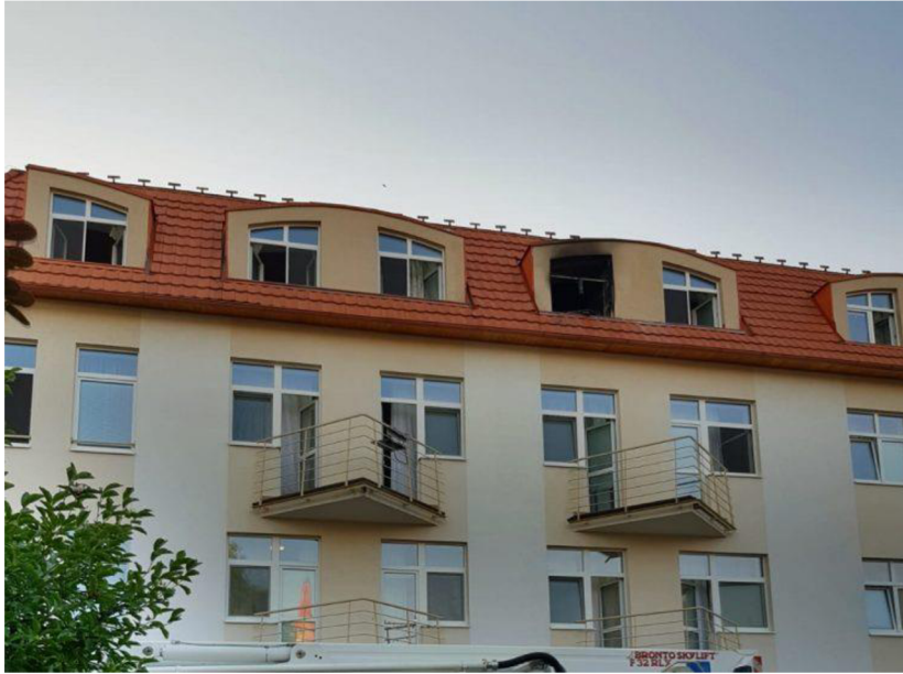
Obrázek 2. Požár v Domově pro seniory v Mšenu ( http://iRozhlas.cz ).
