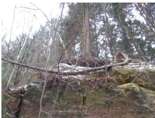
Obr. 14: Příklad škod na skalních terasách - obnažení koř. systémů, por.sk. 240B9, bývalý lom. Leden 2016, foto autor.
