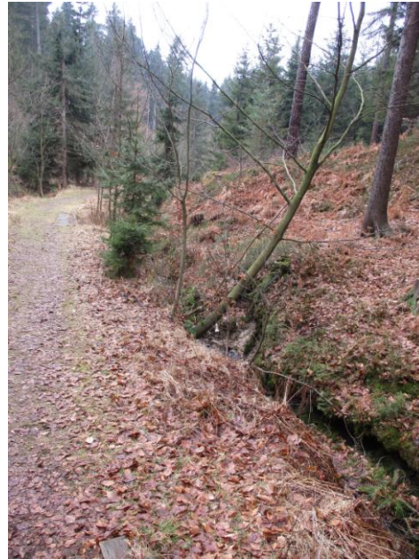
Obr. 13: Erozní škody v údolí v por.sk. 164A13. Březen 2016, foto autor.
