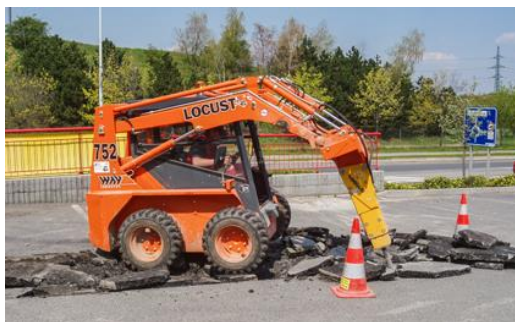
Obrázek 3: Bourání krytu vozovky pomocí kladiva [8]
