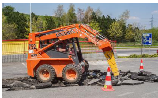
Obrázek 3: Bourání krytu vozovky pomocí kladiva [8]
