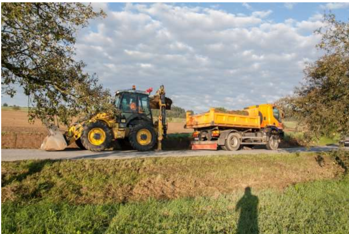
Obr. 21 Fotodokumentace eroze na pozemku č. 1 – odstranění a odvoz naplavené zeminy z příkopu na skládku (29.8.2014 Foto: Martin Havlát)
