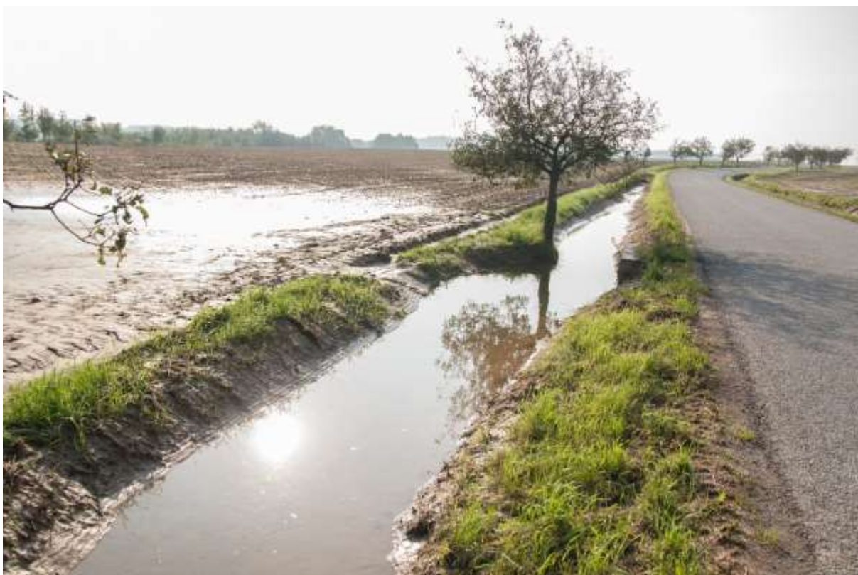
Obr. 23 Fotodokumentace eroze na pozemku č. 1 – „obnovený“ příkop po dalším dešti (4.9.2014 Foto: Martin Havlát)
