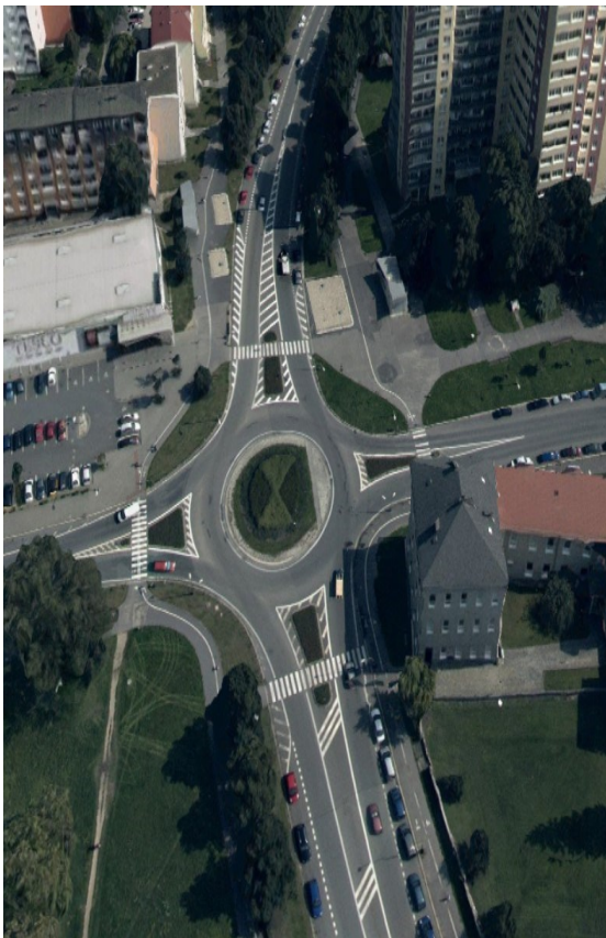
Obr. 4.19 Stav před úpravou
