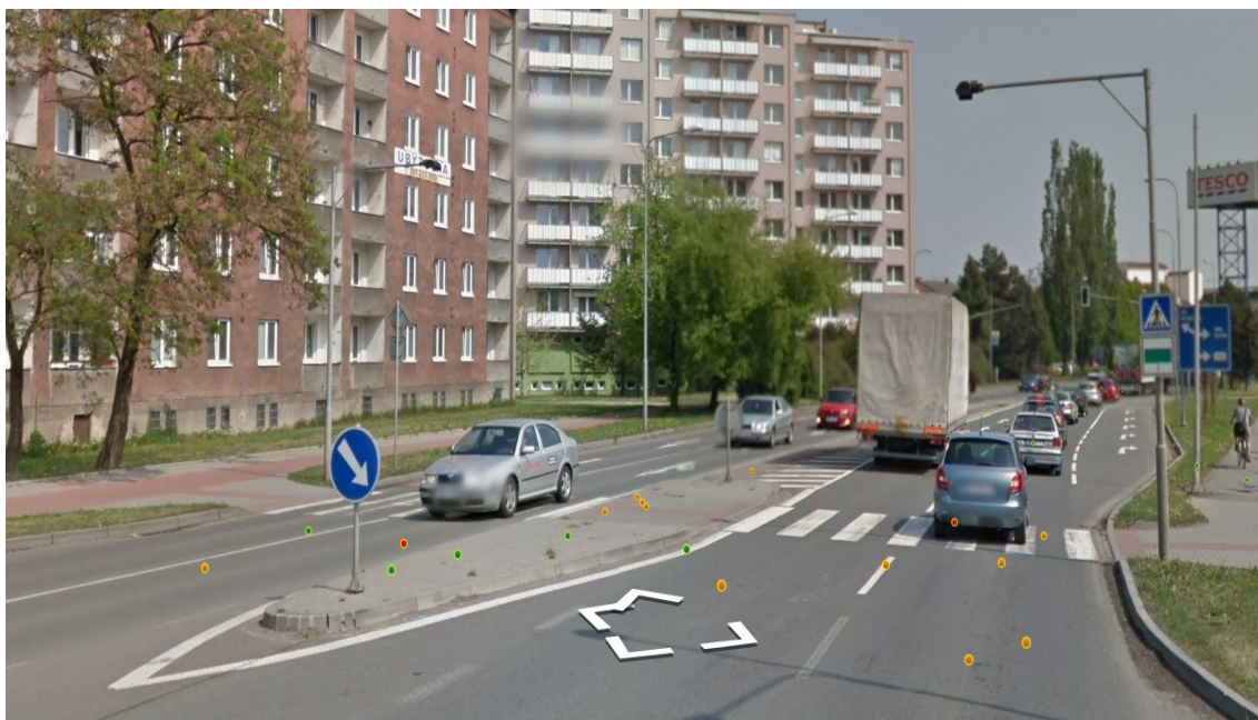
Obr. 4.26 Směr od mostu Legií směrem na ul. Velké Novosady
