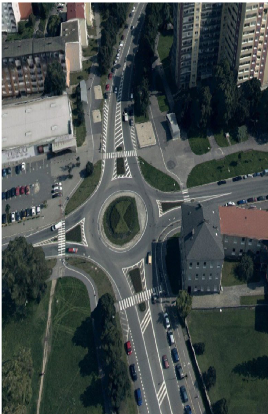
Obr. 4.19 Stav před úpravou
