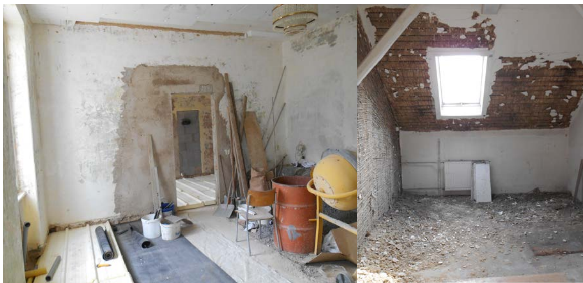
Obrázek 16. Zateplování podlahy v provozovně
