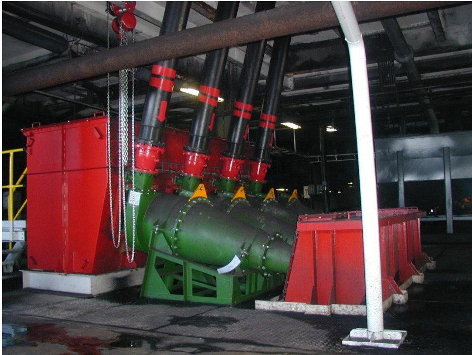
Obrázek č. 7: Těžkokapalinové hydrocyklóny (zdroj OKD, a.s.)
