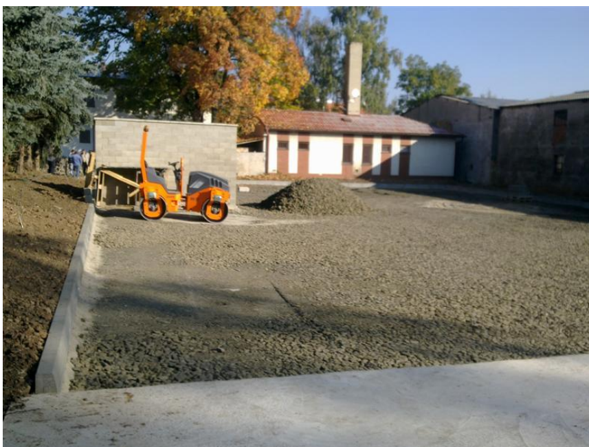
Obrázek 19: Příprava zpevněné plochy sběrného dvora
