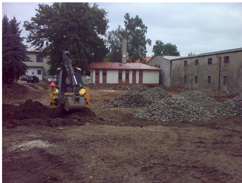
Obrázek 18: Příprava podloží zpevněné plochy sběrného dvora
