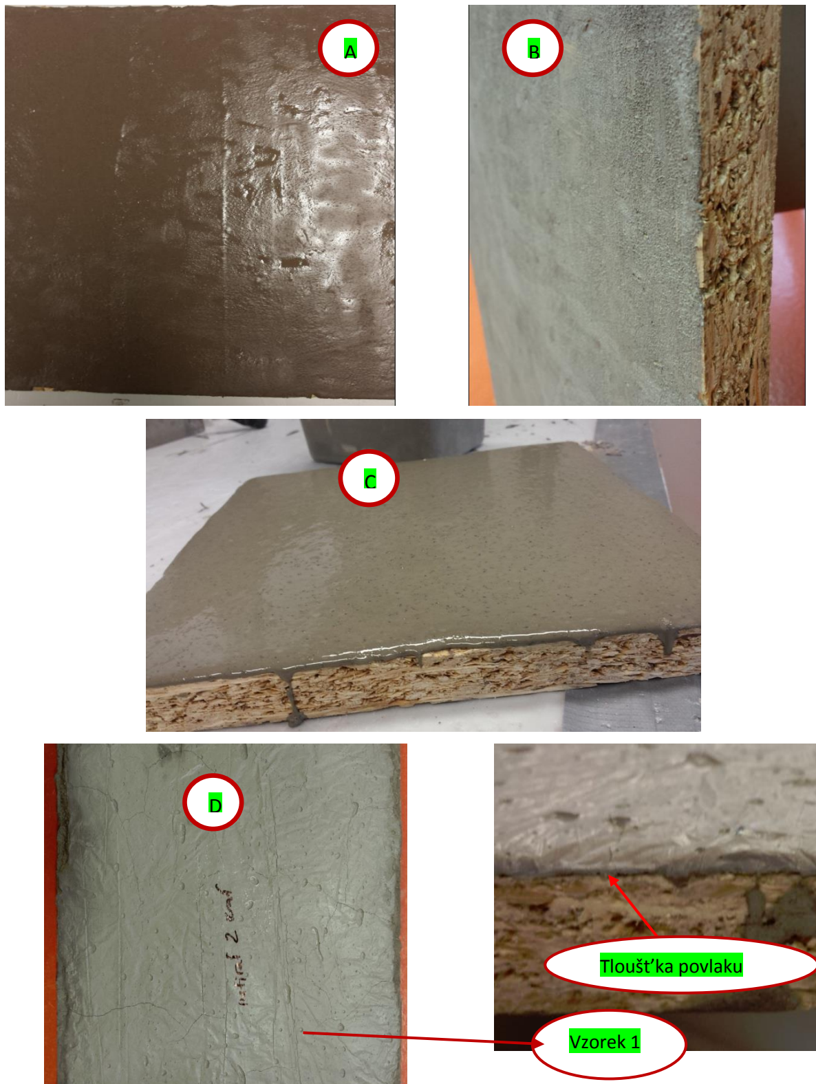
Obr. 18 Postup vytvoření vrstvy na desce OSB; A) natření první vrstvy; B) 1. vrstva po 24 hodinách; C) Natření druhé vrstvy; D) Suché vrstvy po 7 dnech
