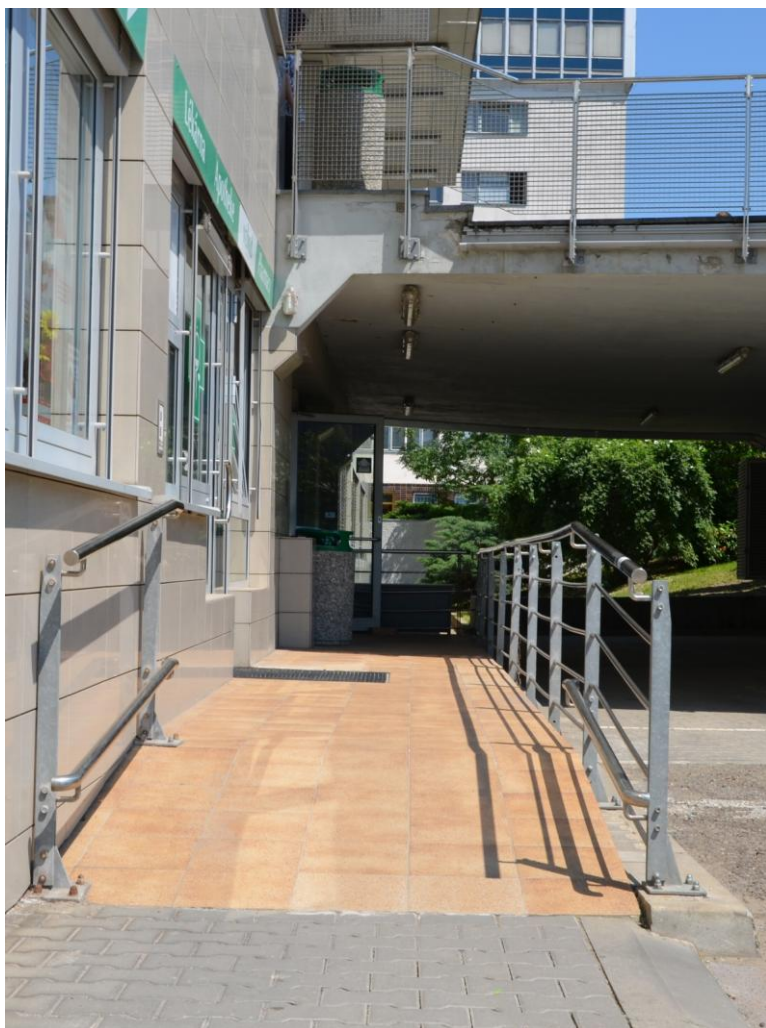
Obr. 12 Bezbariérový přístup na polikliniku na Praze 3.
