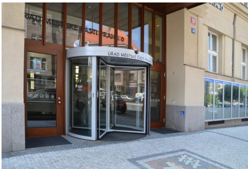
Obr. 16 Vstupní dveře Městského úřadu Prahy 6. Boční dveře by měly umožnit vstup lidem na vozíku, avšak nesplňují povinnou výšku zasklení nebo ochrany před mechanickým poškozením vozíkem. Dále jsou opatřeny systémem Brano, který je pro vozíčkáře velmi těžko překonatelný.
