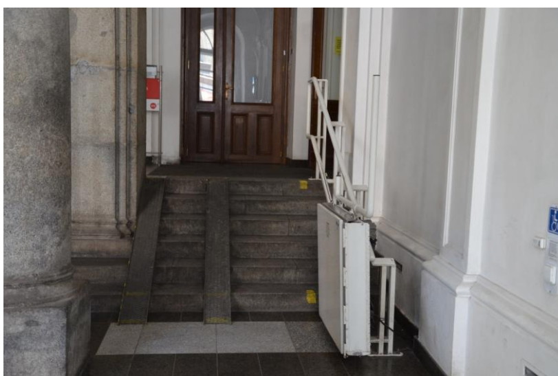
Obr.19 Zdvihací plošina v budově Domu dětí a mládeže na Praze 8.
