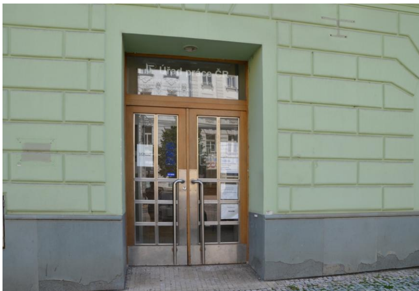
Obr. 17 Vstupní dveře Úřadu práce Prahy 4. Zasklená plocha je chráněna proti mechanickému poškození vozíkem, z požadované strany jsou opatřena pomocnými madly.
