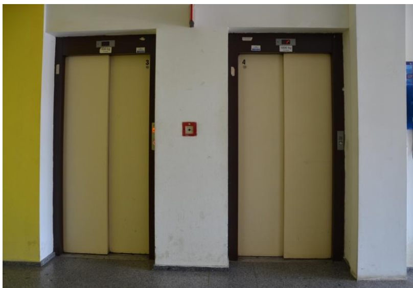
Obr. 20 Výtahy v budově polikliniky na Praze 3. Oba svými rozměry vyhovují pro přepravu osoby na invalidním vozíku.
