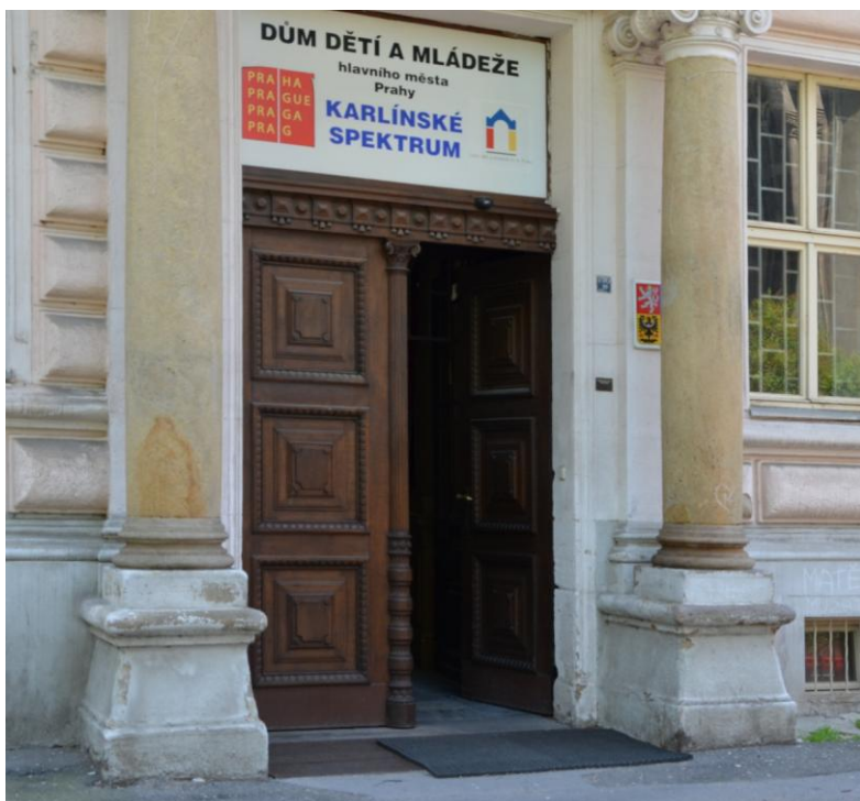
Obr.1 Bezbariérový vstup do Domu dětí a mládeže na Praze 8
