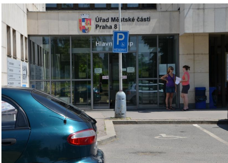
Obr.27 Vyhrazené stání před Městským úřadem Prahy 8. Nevyhovujícím prvkem jsou zde hlavně nesnížené obrubníky.
