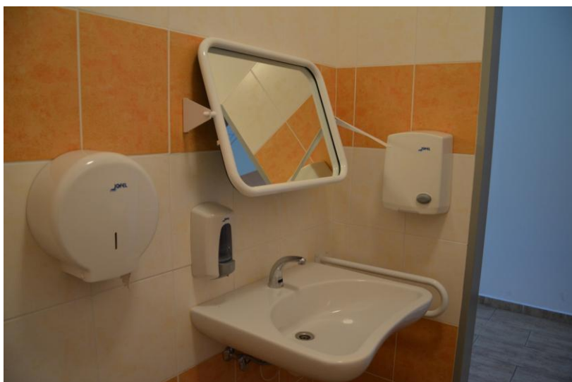
Obr.25 Toaleta pro tělesně postižené v budově Městského úřadu Prahy 10. Vyhláška 389/2009 Sb., zmiňuje pouze výtokovou baterii s pákovým ovládním, i když automatická baterie ovládním ulehčuje.
