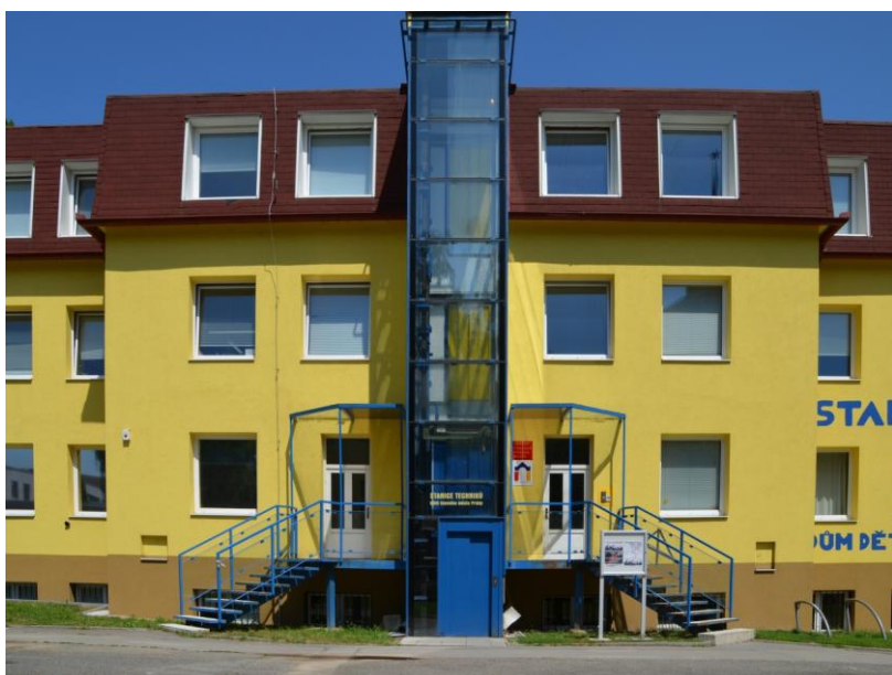
Obr.21 Ukázka venkovního výtahu pro vozíčkáře, který tak zpřístupňuje celou budovu Domu dětí a mládeže Prahy 6.
