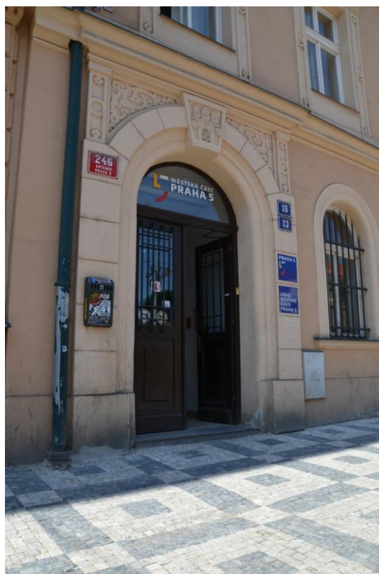
Obr.3 Vstup do budovy Městského úřadu Prahy 5. Před vstupem schod vyšší než 200 mm bez rampy či jiných bezbariérových řešení.
