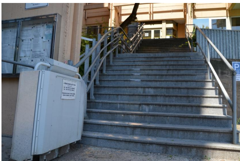
Obr.7 Samoobslužná zdvižná plošina u budovy Finančního úřadu Prahy 8.
