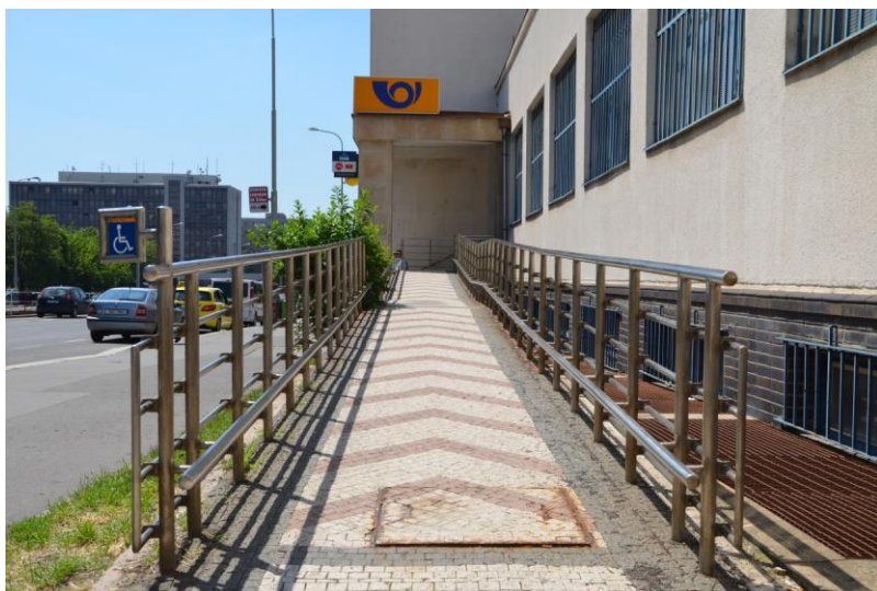
Obr. 6 Rampa splňující požadavky vyhlášky 389/2009 Sb., u budovy pošty na Praze 3.
