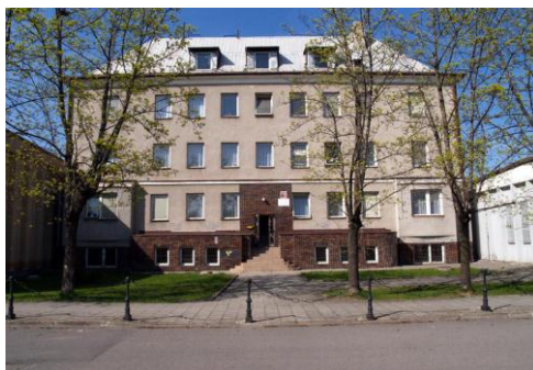
Fotografie číslo 5: Hlavní budova DDM na ulici Janáčkova 91
