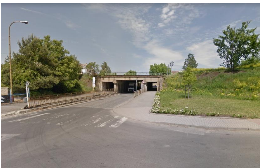
Obr. 18 – Viadukt v Turnově
