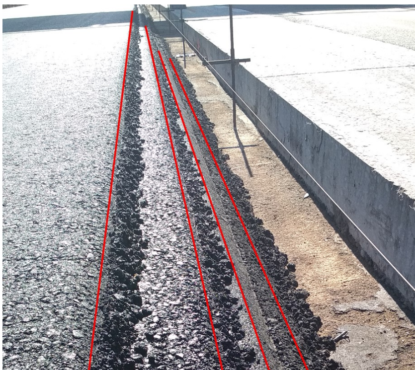
Obrázok 23 Ukážka odskoku pokladaných vrstiev [autor]
