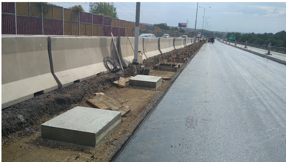
Obrázok 18 Budovanie monolitických pätiiek v SDP [autor]
