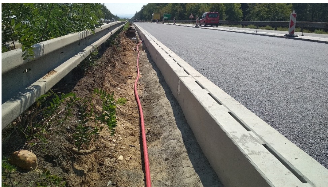
Obrázok 22 Ukážka štrbinového žľabu [autor]
