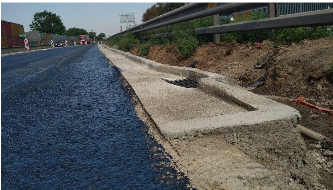
Obrázok 21 Ukážka monolitického žľabu [autor]
