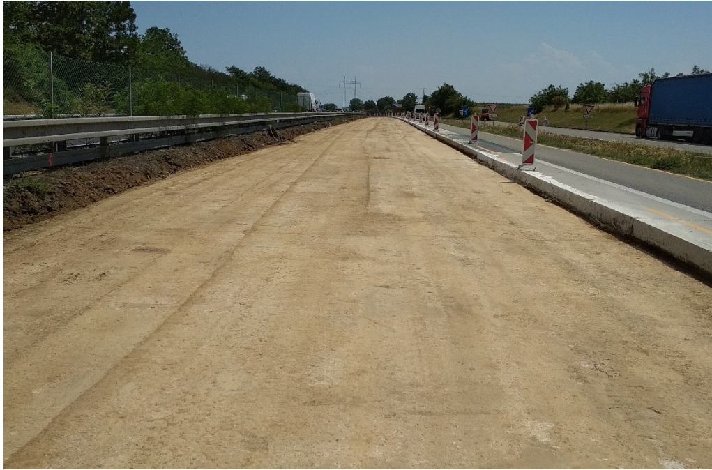
Obrázok 13 Ukážka vyčistenej podkladovej vrstvy [autor]
