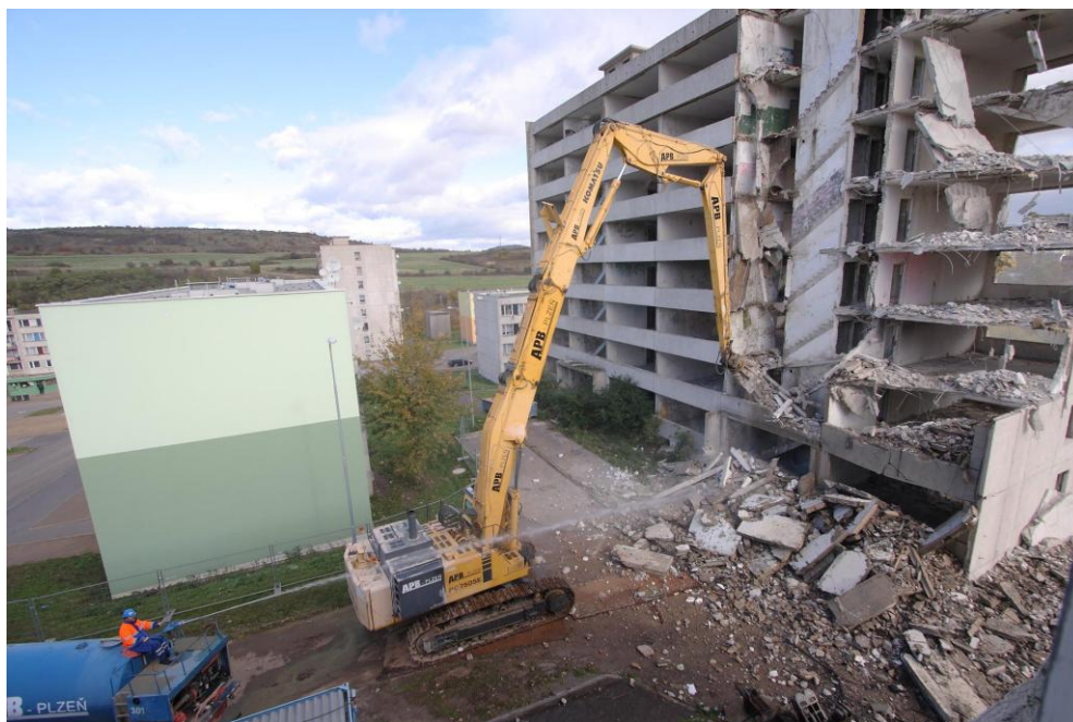
Obr. 10: Demolice panelového domu na mosteckém sídlišti Chanov (Zdroj: ABP Plzeň 2016)
