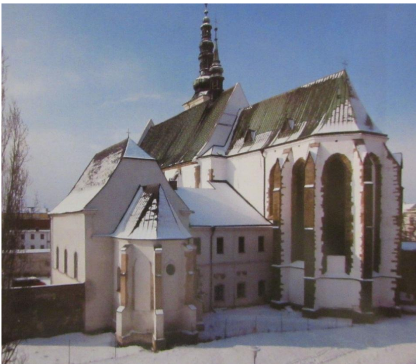
63. Pohled na presbytář klášterního kostela v Prostějově.
