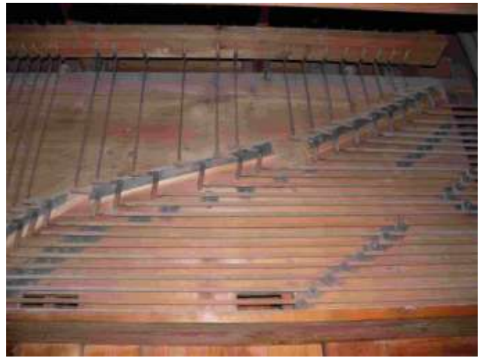
8. Polná – rozvod táhel ve vodících kladkách (foto autor)
