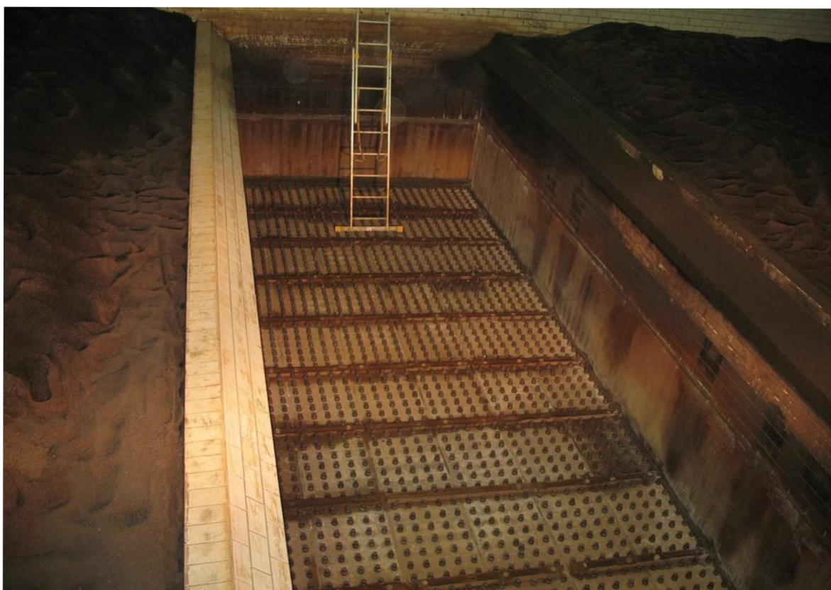
2. Rekonstrukce pískových filtrů
