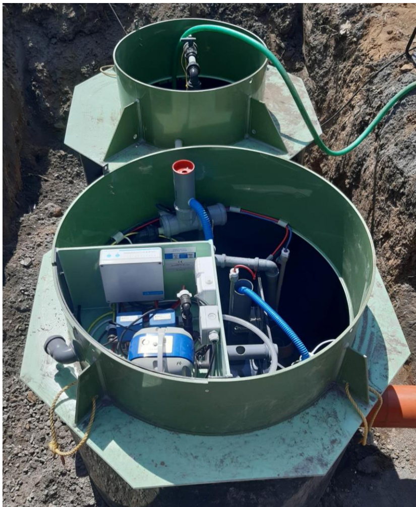
Obr. 9: Ukázka zabudované ČOV (vlastní foto, 14. 6. 2023)
